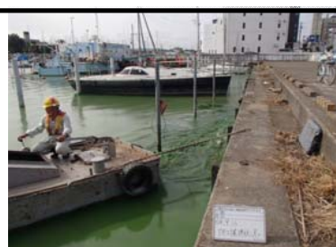
作業船によるアオコ攪拌作業③
