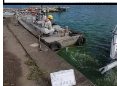
作業船によるアオコ攪拌作業④
