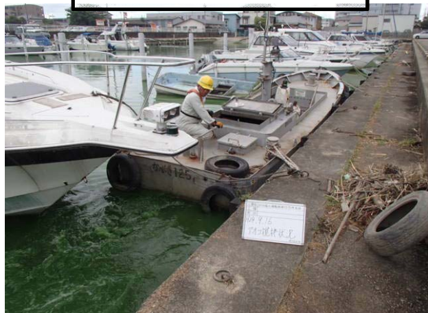
作業船によるアオコ攪拌作業①
