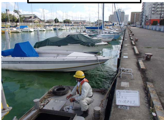
作業船によるアオコ攪拌作業②
