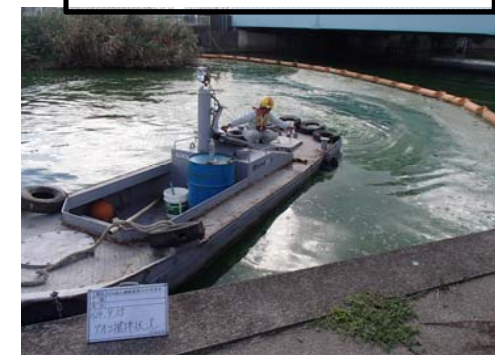
作業船によるアオコ攪拌作業④
