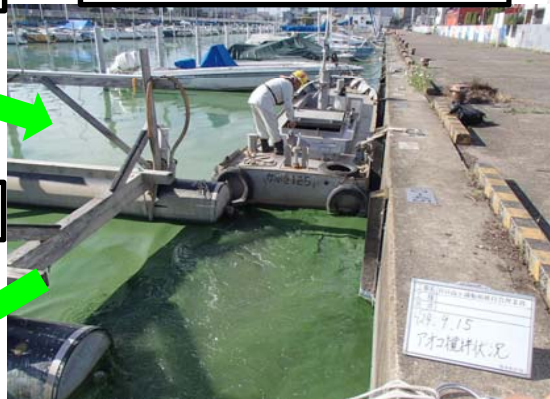
作業船によるアオコ攪拌作業②
