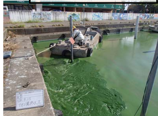
作業船によるアオコ攪拌作業③
