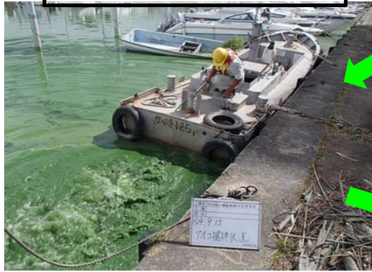
作業船によるアオコ攪拌作業①
