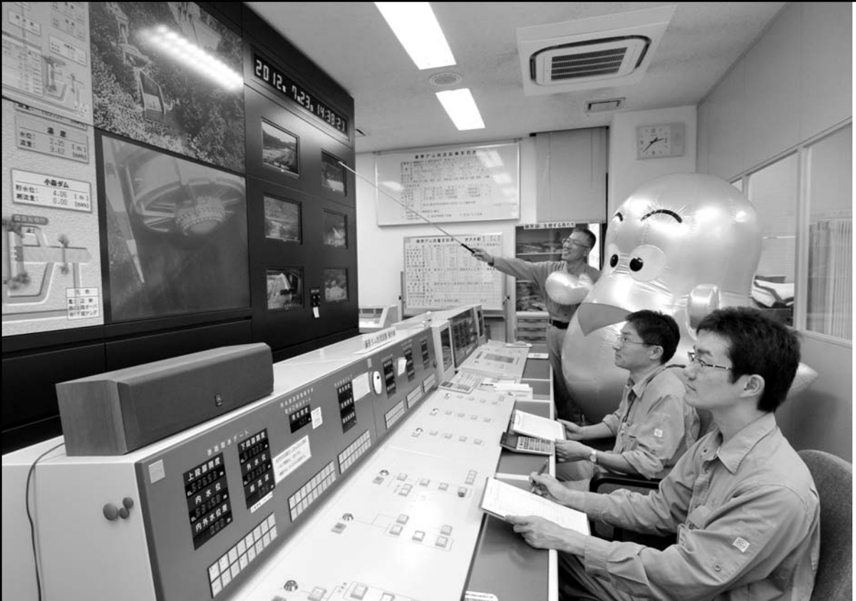
藤原ダム管理支所内の制御室。ここでダムをコントロールしているんだよ
