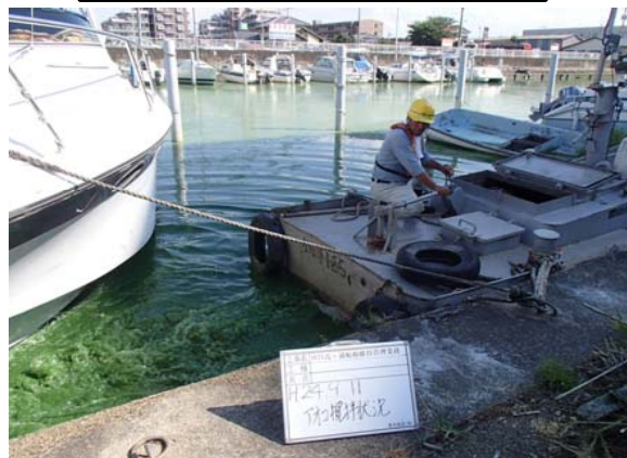
作業船によるアオコ攪拌作業②
