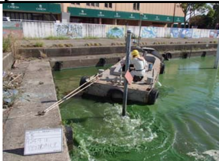
作業船によるアオコ攪拌作業④
