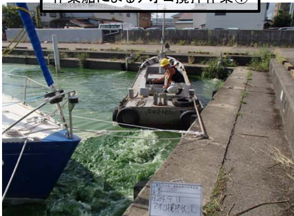
作業船によるアオコ攪拌作業②
