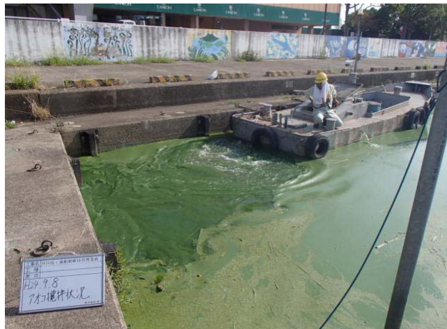
作業船によるアオコ攪拌作業①
