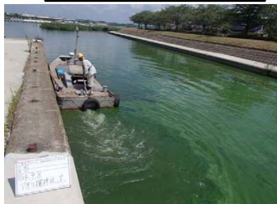
作業船によるアオコ攪拌作業②
