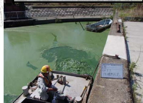
作業船によるアオコ攪拌作業④
