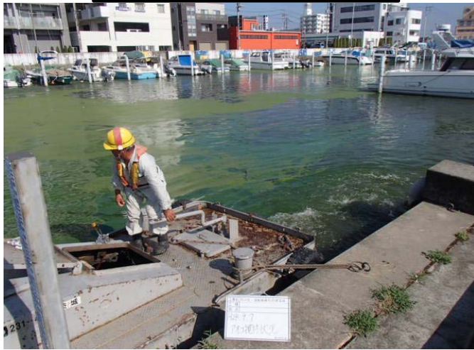
作業船によるアオコ攪拌作業②
