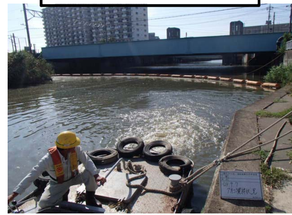
作業船によるアオコ攪拌作業⑤
