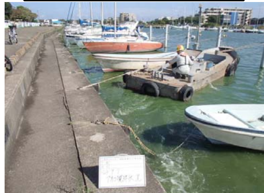
作業船によるアオコ攪拌作業③
