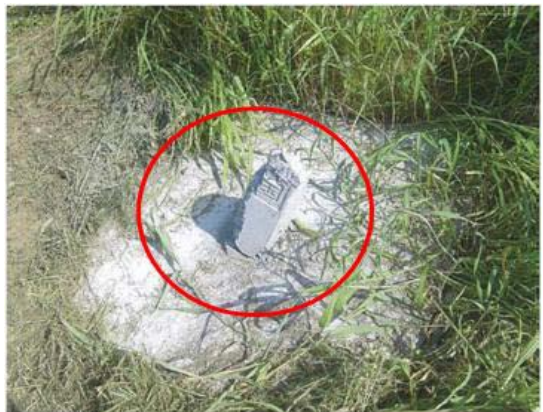
距離標損傷状況
