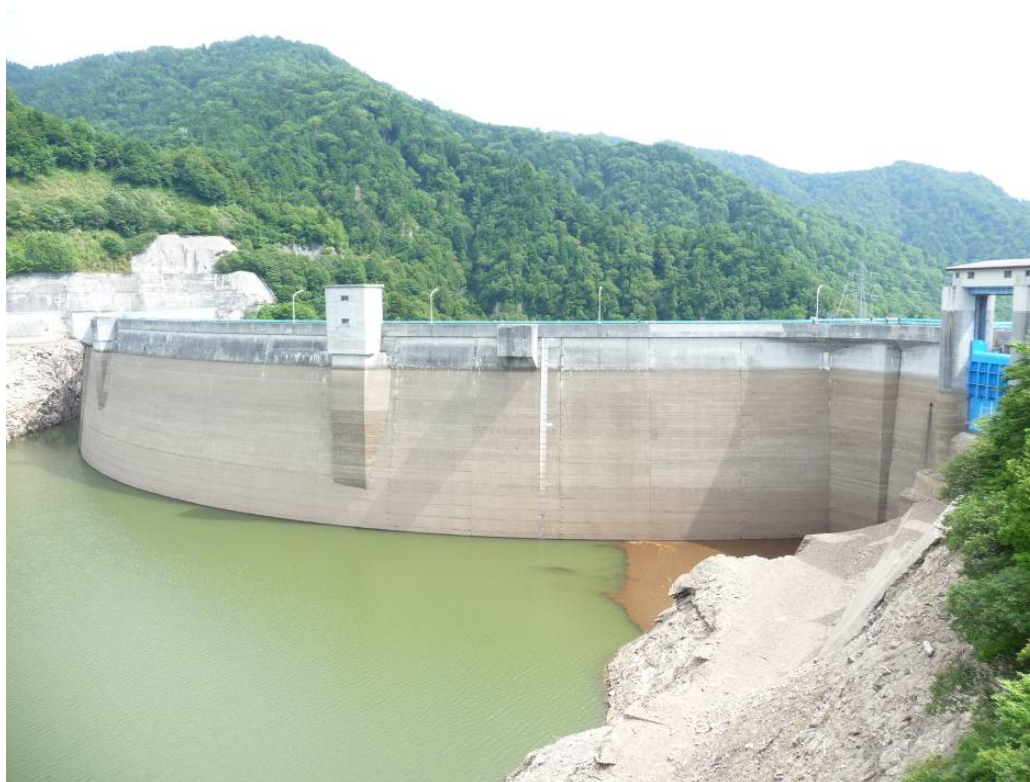
写真：矢木沢ダム
