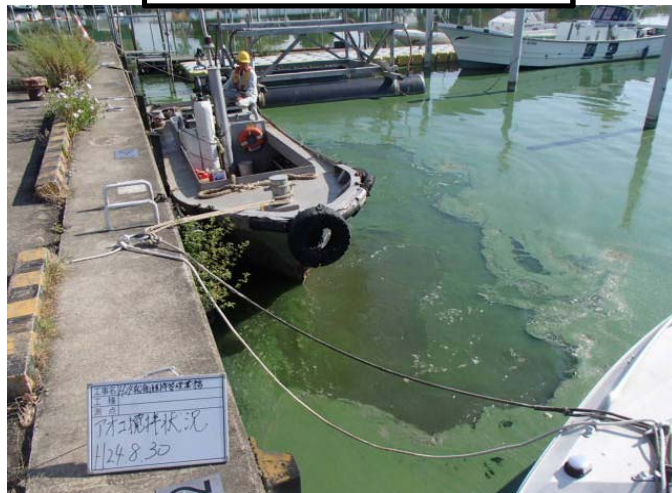
作業船によるアオコ攪拌作業②
