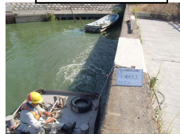
作業船によるアオコ攪拌作業⑤
