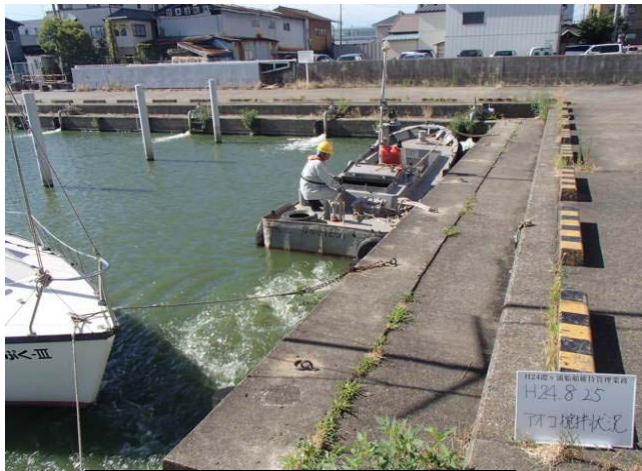
作業船によるアオコ攪拌作業②
