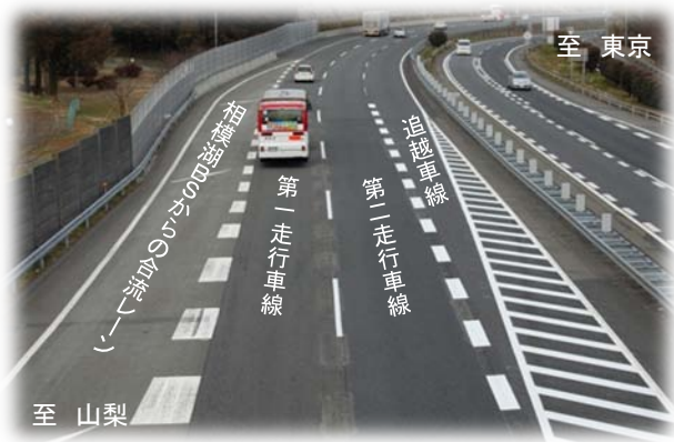
車線運用状況写真
