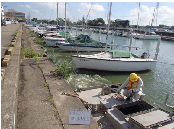
作業船によるアオコ攪拌作業①
