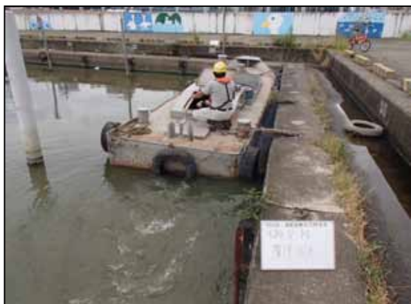
作業船によるアオコ攪拌作業
