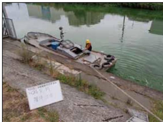
作業船によるアオコ攪拌作業
