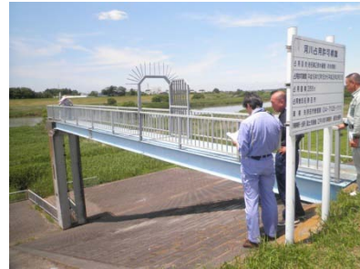
↑ 樋管の履行検査実施状況
