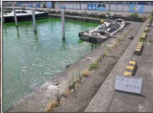
作業船によるアオコ攪拌作業
