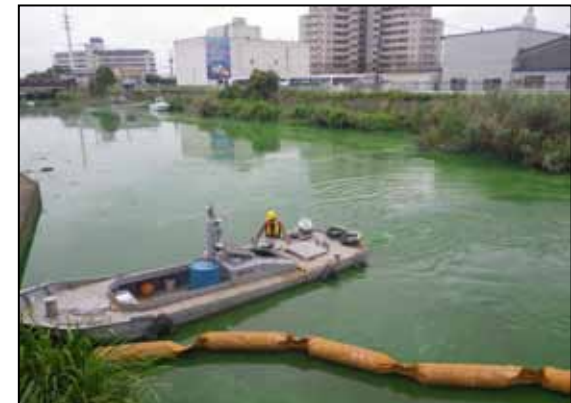
作業船によるアオコ攪拌作業
