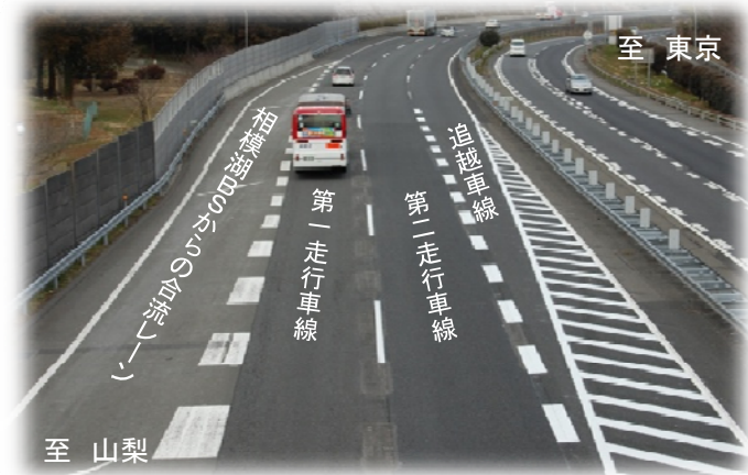
車線運用状況写真
