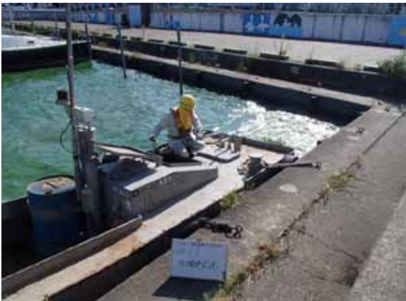
作業船によるアオコ攪拌作業
