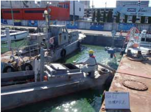
作業船によるアオコ攪拌作業
