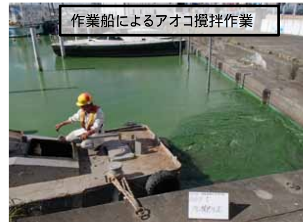
作業船によるアオコ攪拌作業
