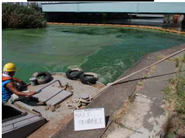
作業船によるアオコ攪拌作業
