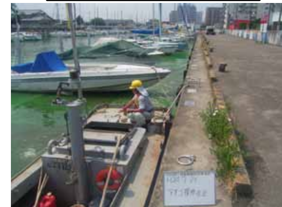
作業船によるアオコ攪拌作業
