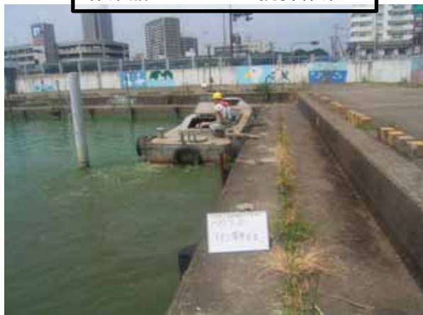
作業船によるアオコ攪拌作業
