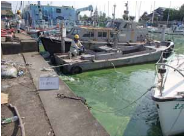
作業船によるアオコ攪拌作業
