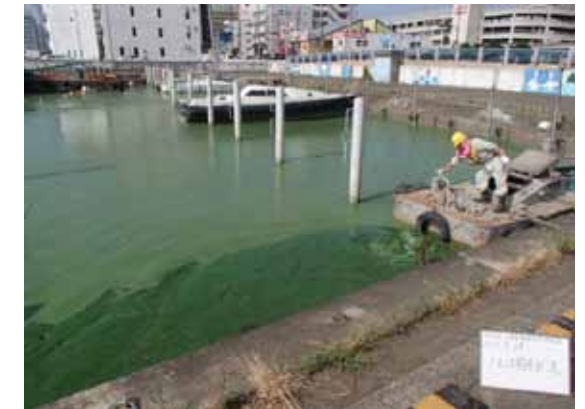
作業船によるアオコ攪拌作業
