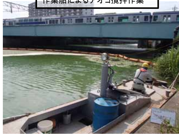
作業船によるアオコ攪拌作業
