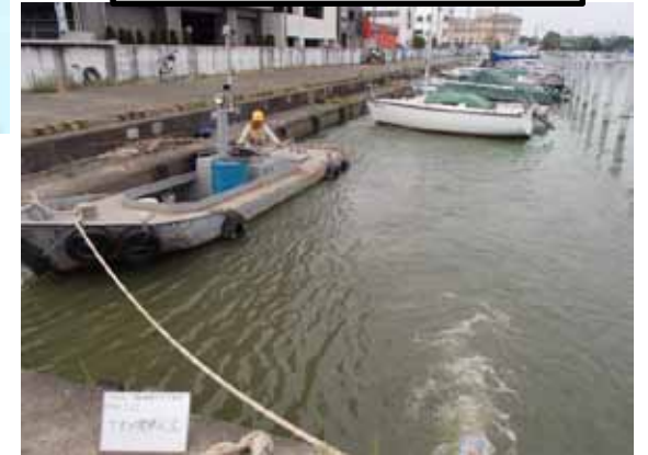
作業船によるアオコ攪拌作業
