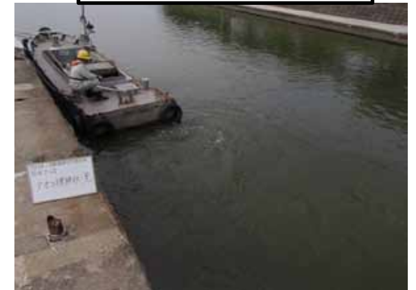
作業船によるアオコ攪拌作業
