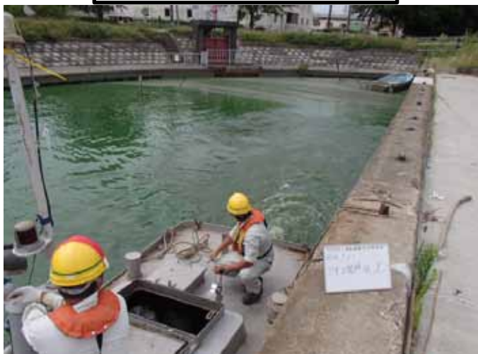
作業船によるアオコ攪拌作業③
