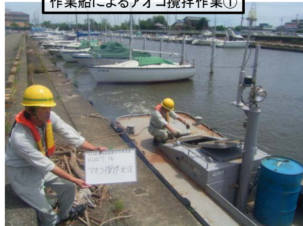
作業船によるアオコ攪拌作業①
