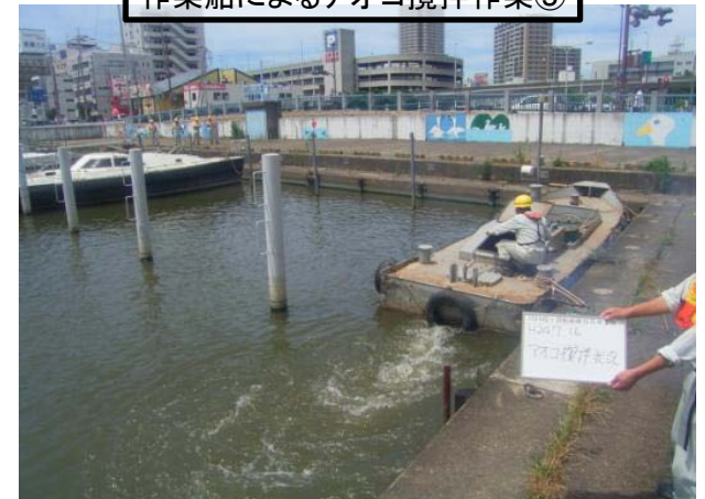
作業船によるアオコ攪拌作業③
