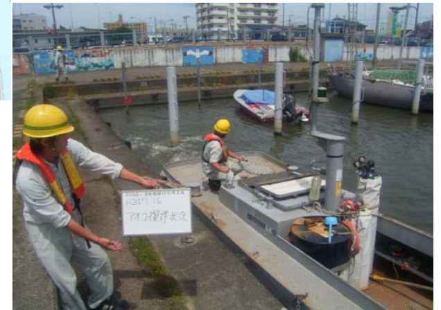
作業船によるアオコ攪拌作業③
