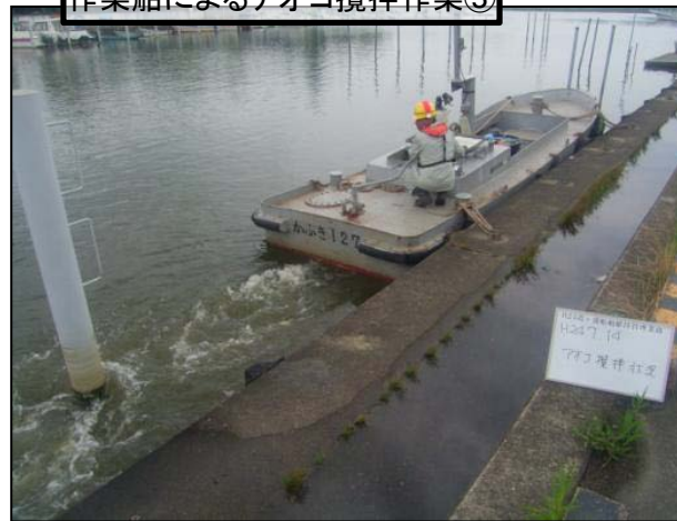
作業船によるアオコ攪拌作業③
