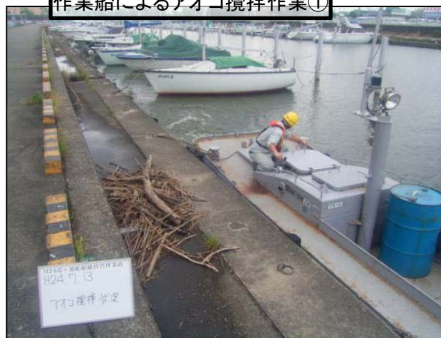
作業船によるアオコ攪拌作業①
