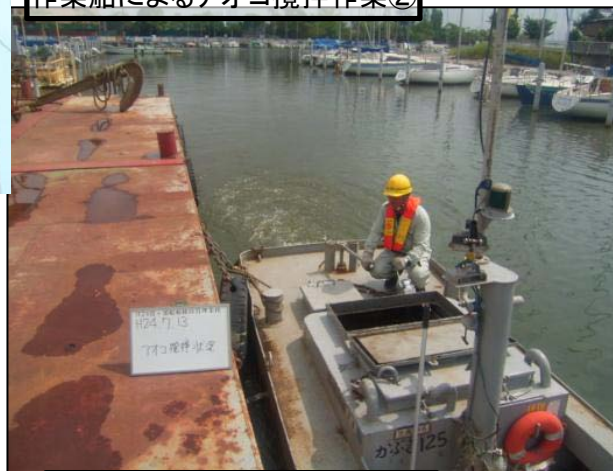
作業船によるアオコ攪拌作業③
