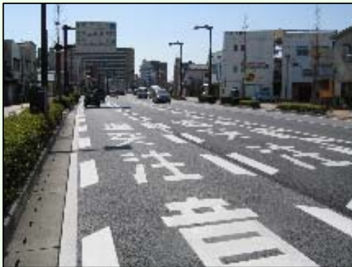
←路面標示「追突注意」とタップライン
