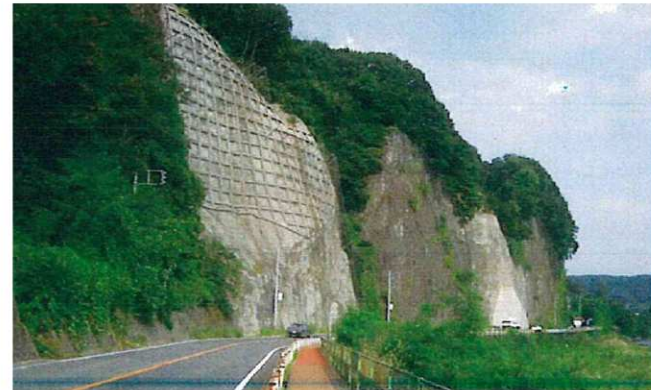
災害復旧対策後 (H19.8撮影)
