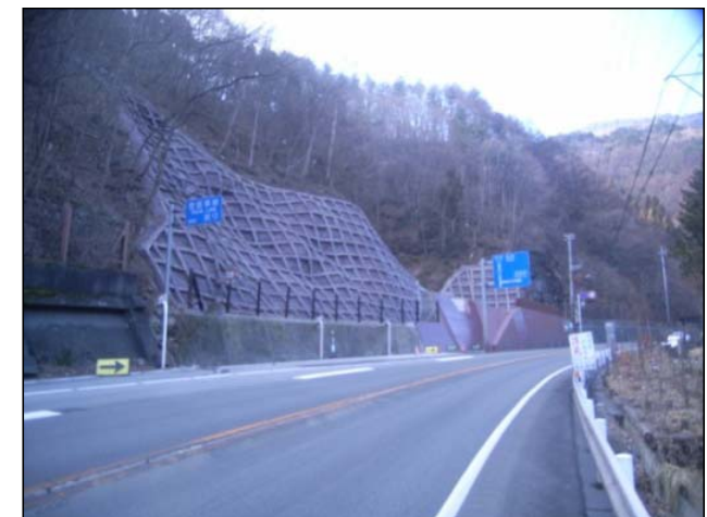
国道137号 要対策箇所 完成後
