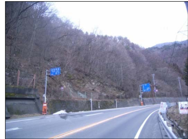
国道137号 要対策箇所 着工前
