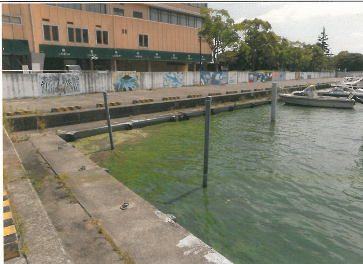
西浦中岸1.50km-100m レベル4
