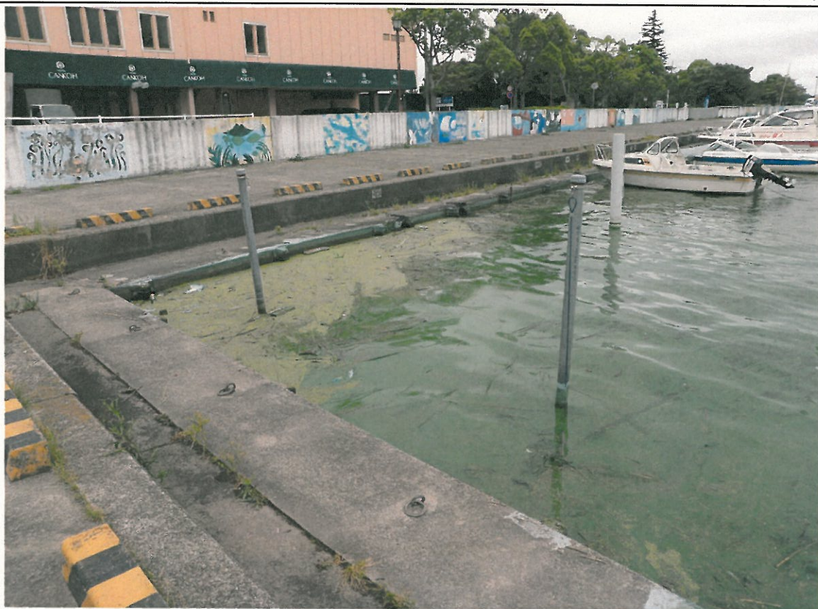
西浦中岸1.50km-100m レベル3~4
