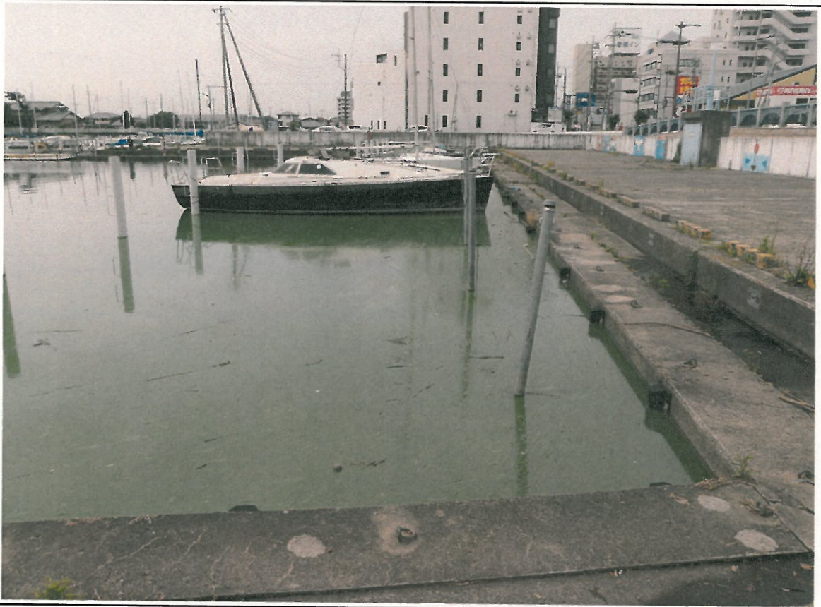
西浦中岸1.50km-100m レベル4
