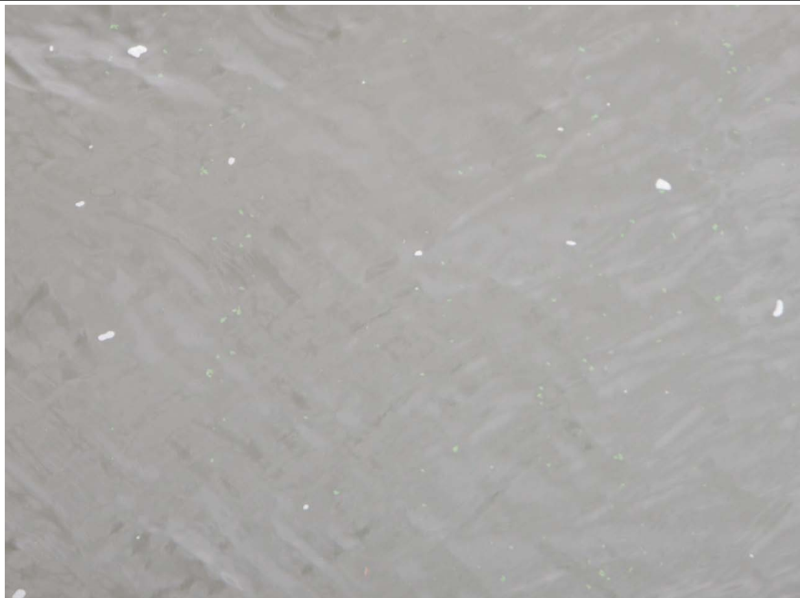
西浦右岸47.25km+50 備前川 レベル2～3
