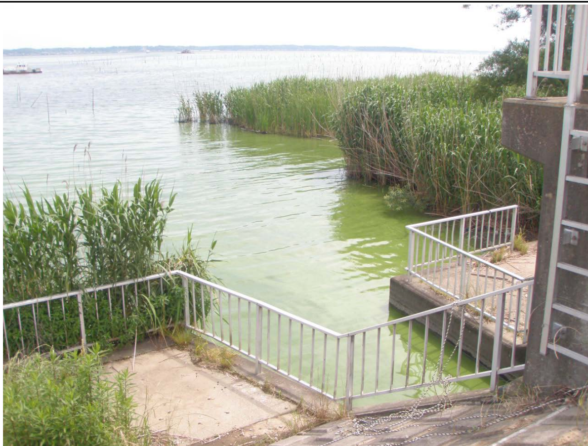
西浦右岸44.25km-50m 大室樋管 レベル3~4
