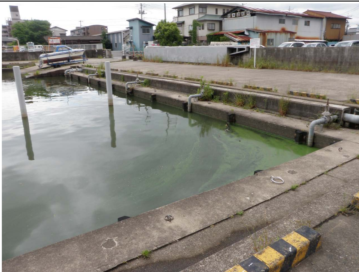
西浦中岸1.25km+150m レベル3~4
