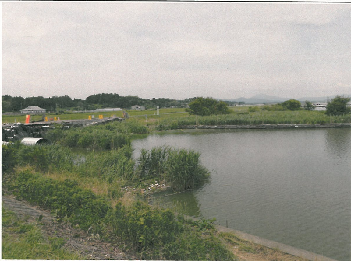
西浦中岸35.00km レベル3~4
