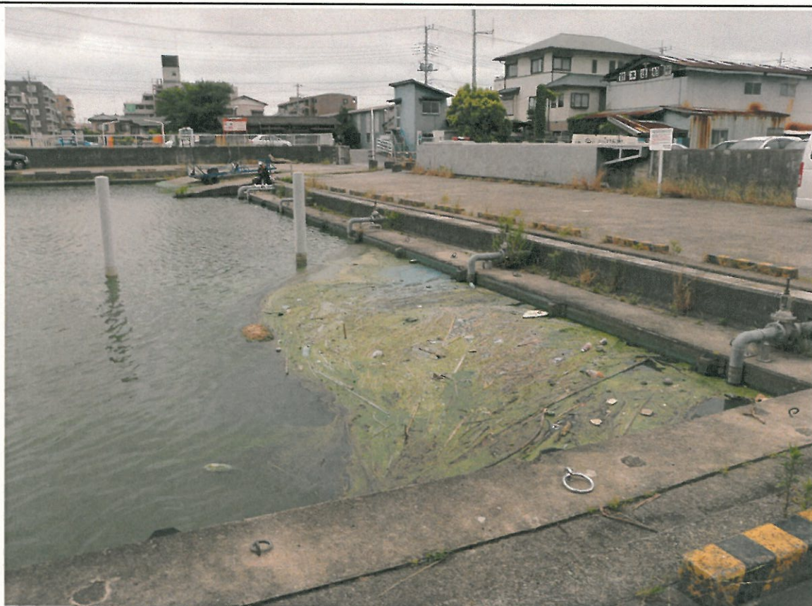
西浦中岸1.25km+200m レベル4~5(9:20)
