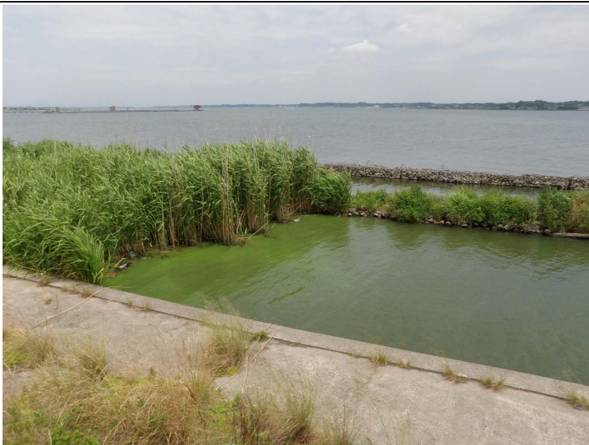
西浦中岸23.50km-100m レベル3~4
