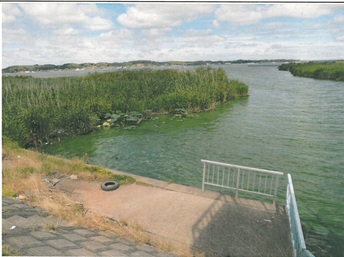
西浦中岸36.50km-50m レベル4
