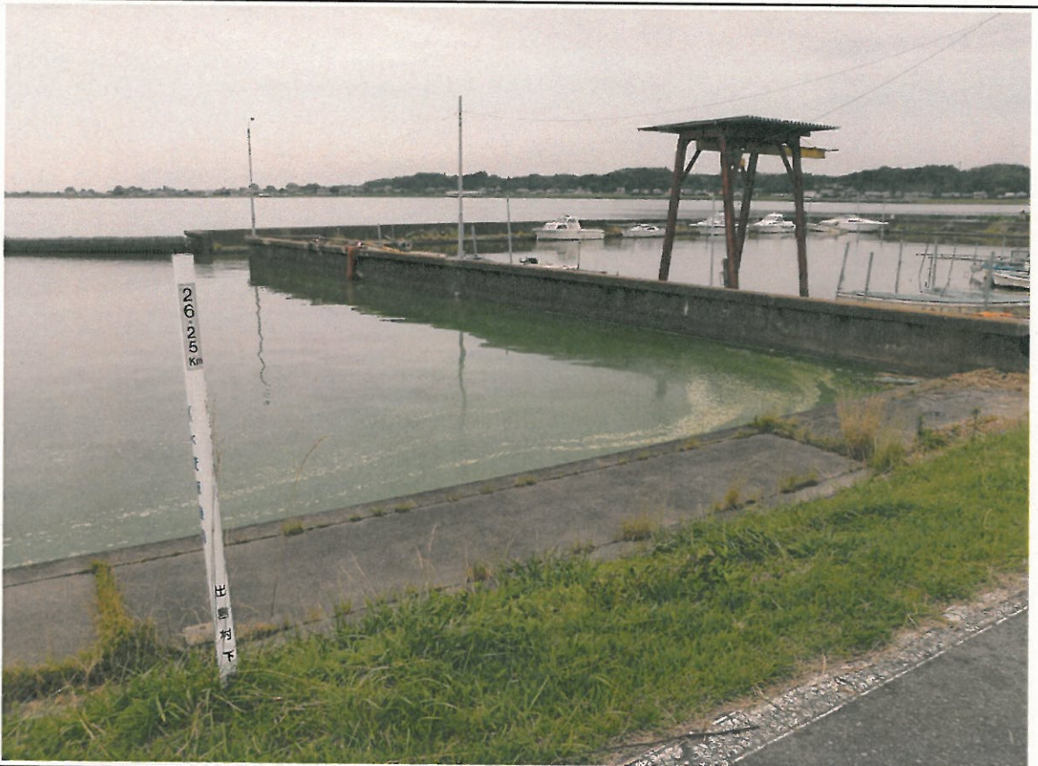
西浦中岸26.25km-20m レベル3~4
