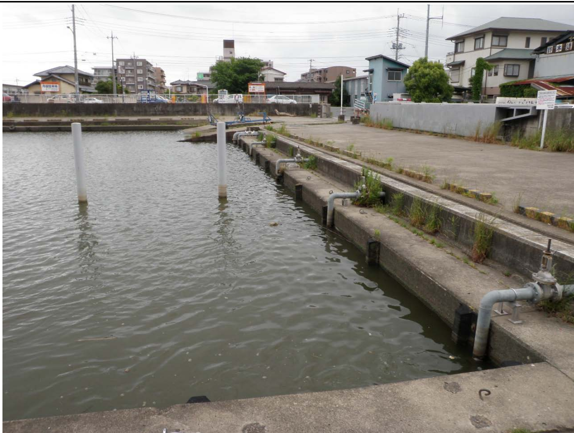
西浦中岸1.25km+200m レベル2~3
