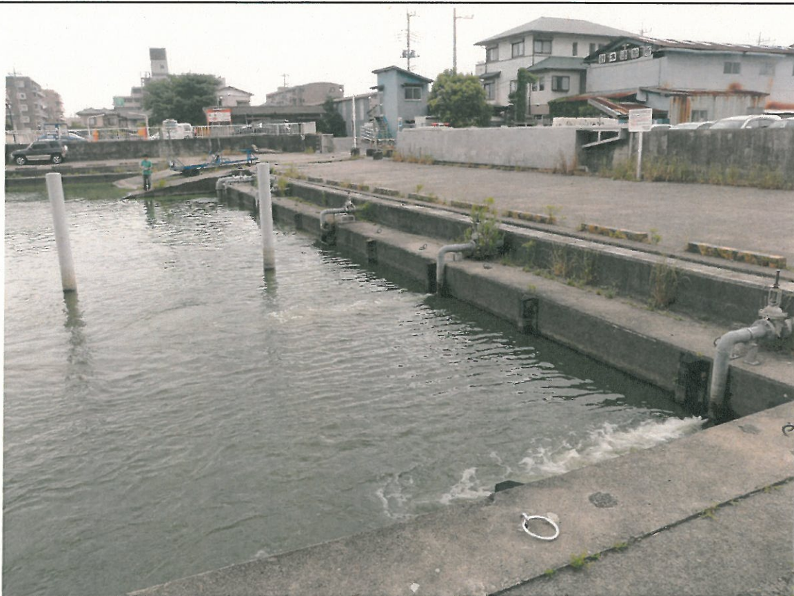
西浦中岸1.25km+200m レベル2~3
