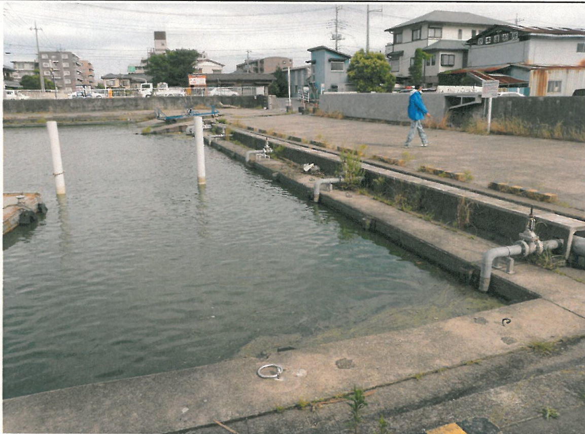
中岸1.25km+200m 午後よりアオコの除去作業が行われ、レベル3~4になっていた。(15:35確認)
