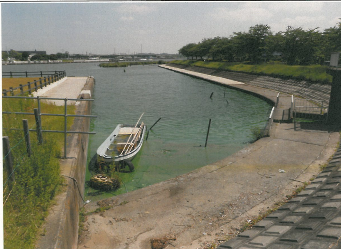
西浦中岸1.00km-50m レベル4
