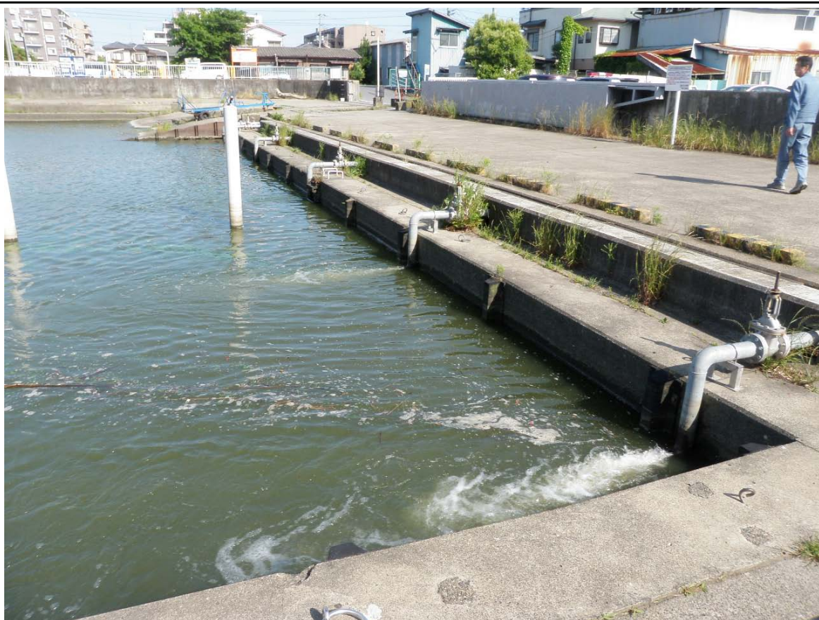
西浦中岸1.25km+200m レベル2~3
