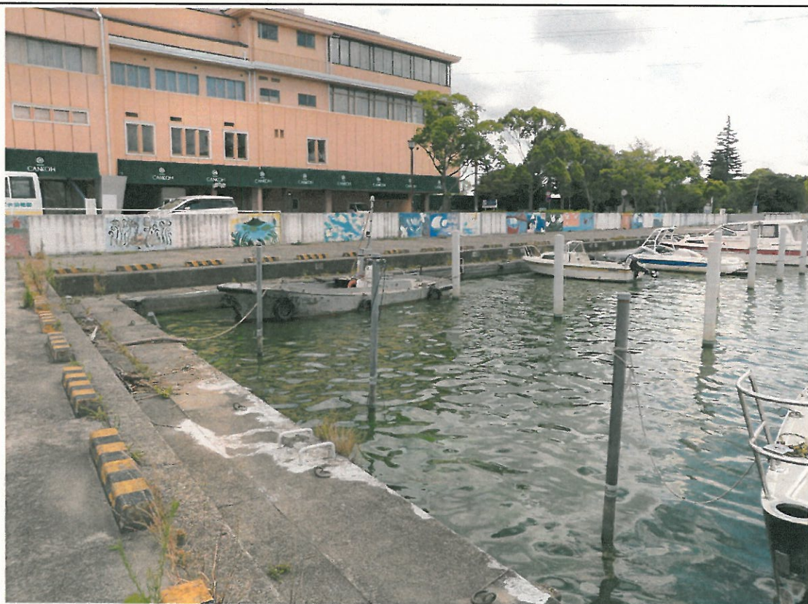
西浦中岸1.50km-150m レベル4
