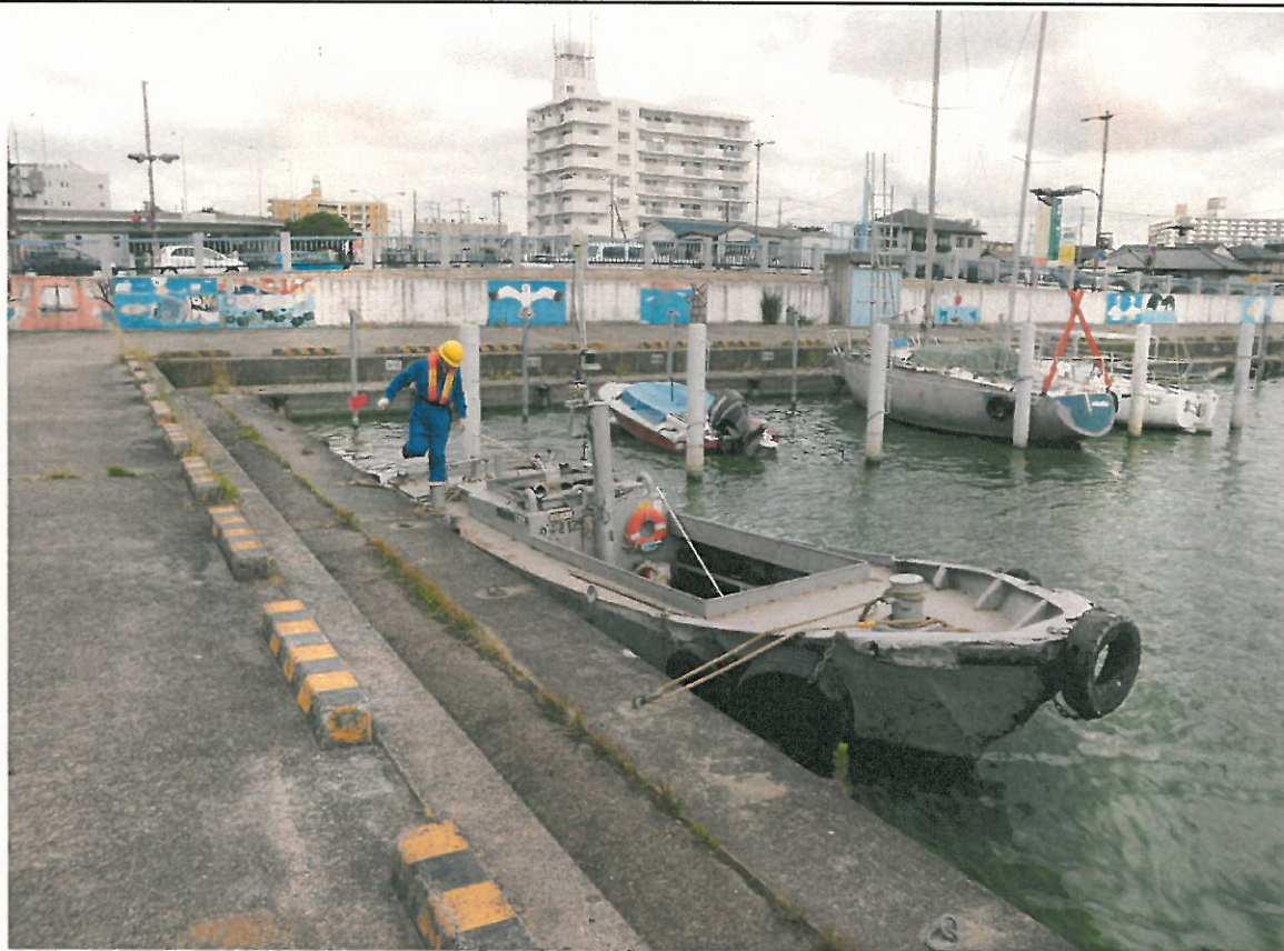
西浦中岸1.50km-100m レベル4
