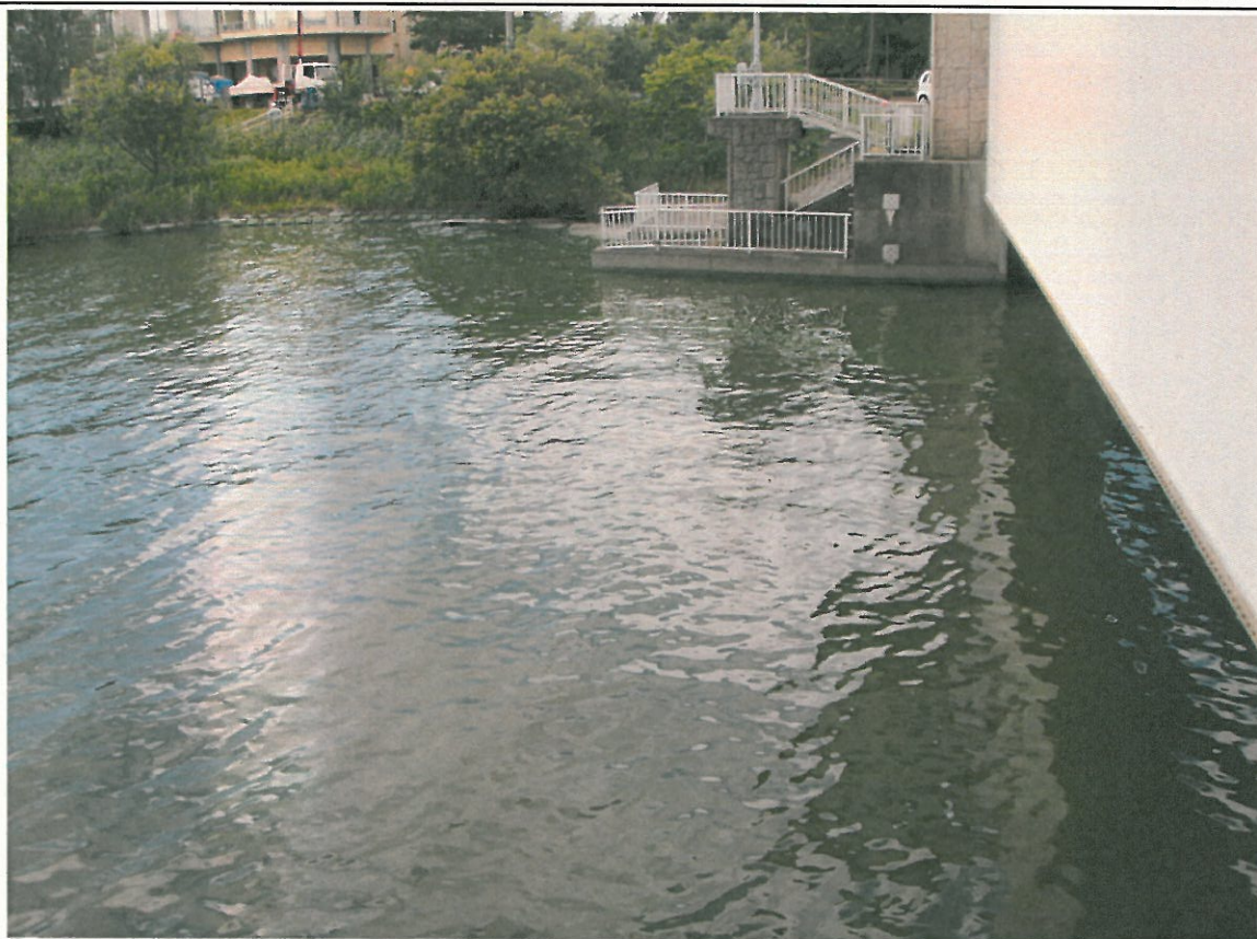
西浦右岸47.25km+50m 備前川 レベル4
