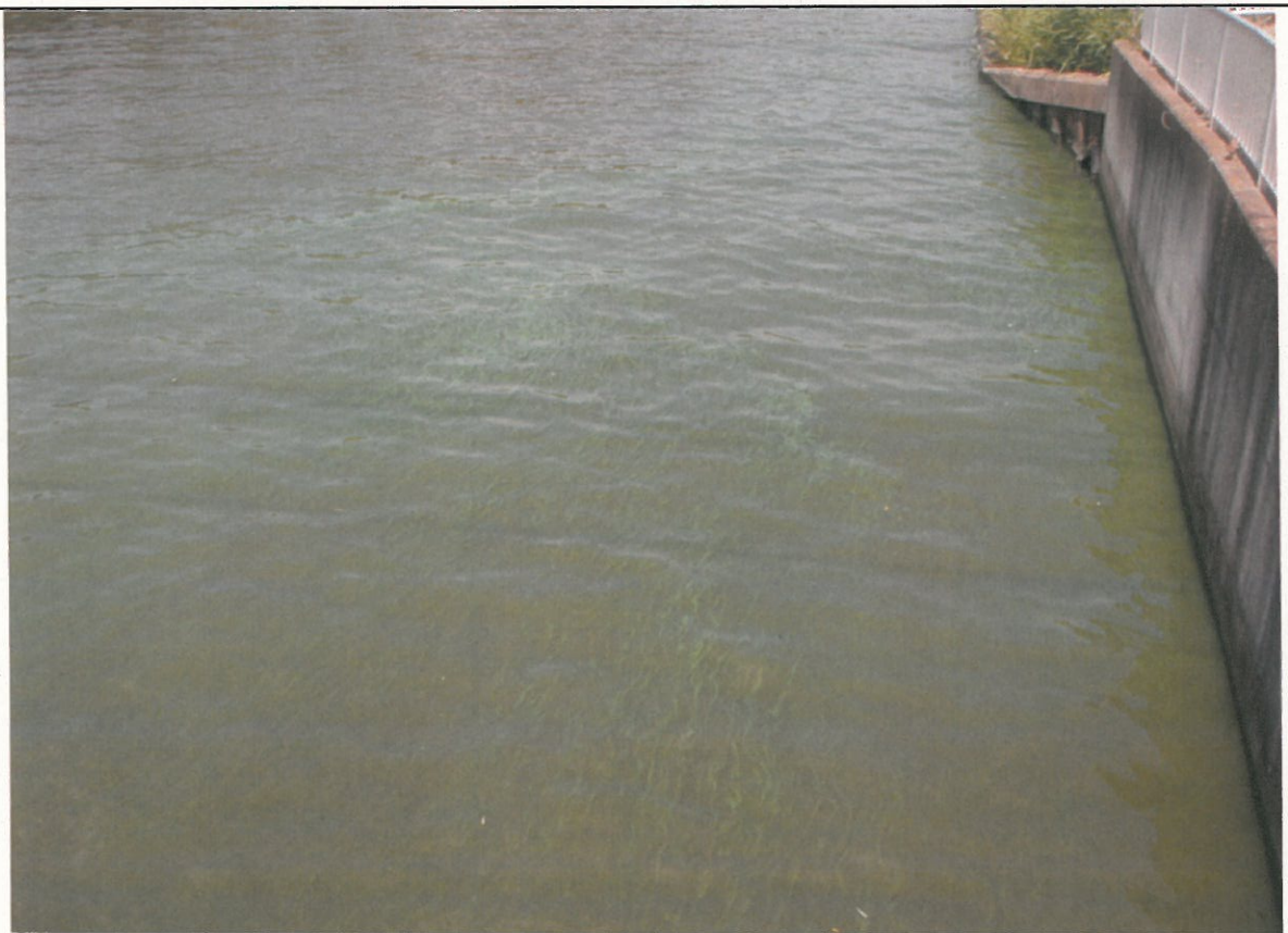
西浦右岸47.25km+50m 備前川 レベル3~4
