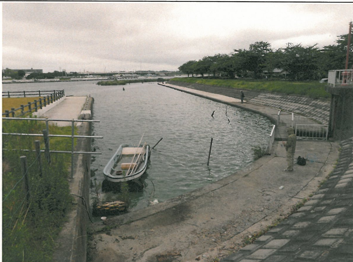
西浦中岸1.00km-50m レベル3
