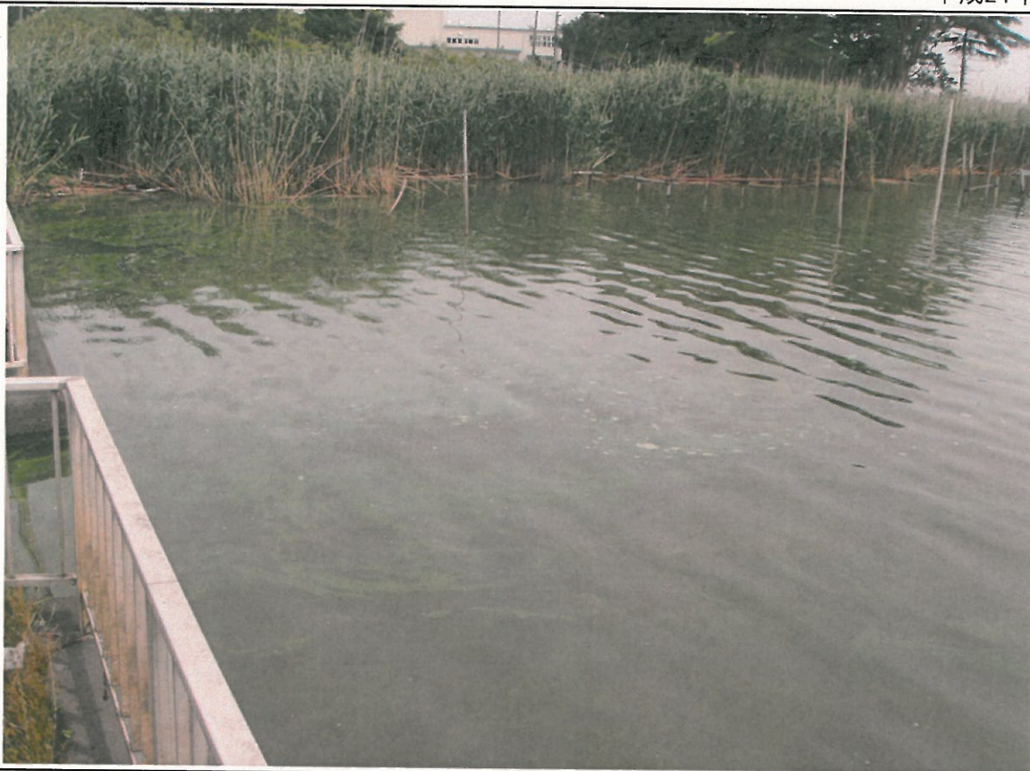
西浦右岸44.75km+40m 廻戸揚排水樋管 レベル3~4
