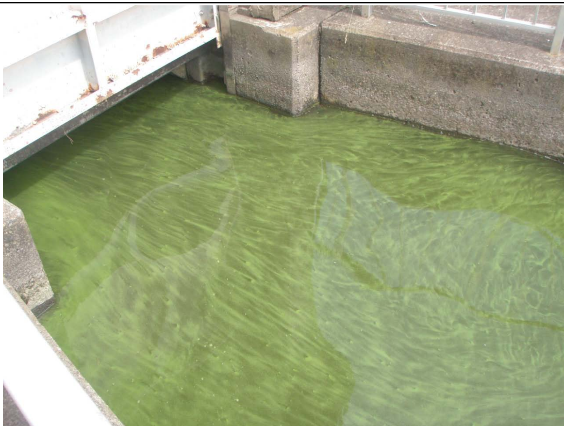
西浦右岸47.25km+50m 備前川 レベル3~4
