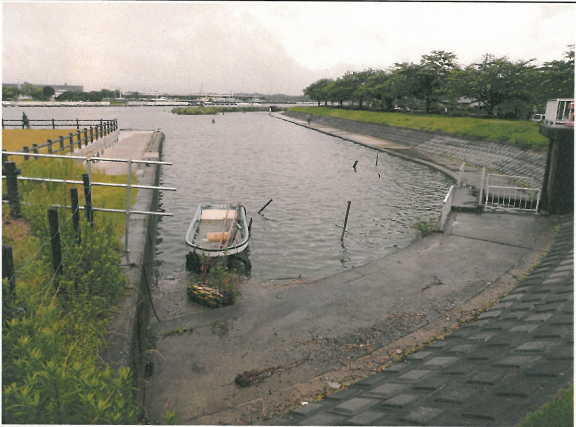
西浦中岸1.00km-50m レベル3
