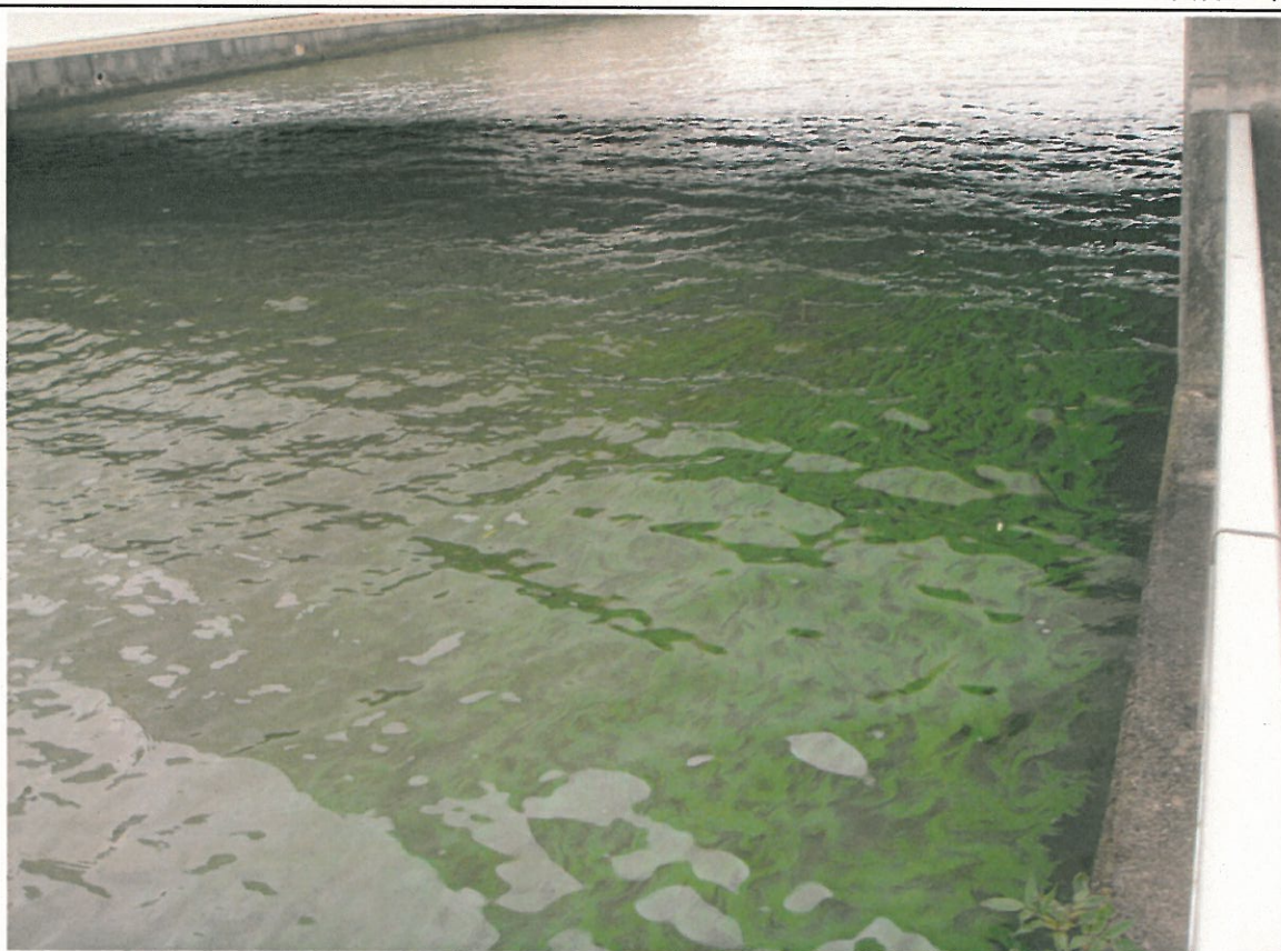
西浦右岸47.25km+50m 備前川 レベル3~4
