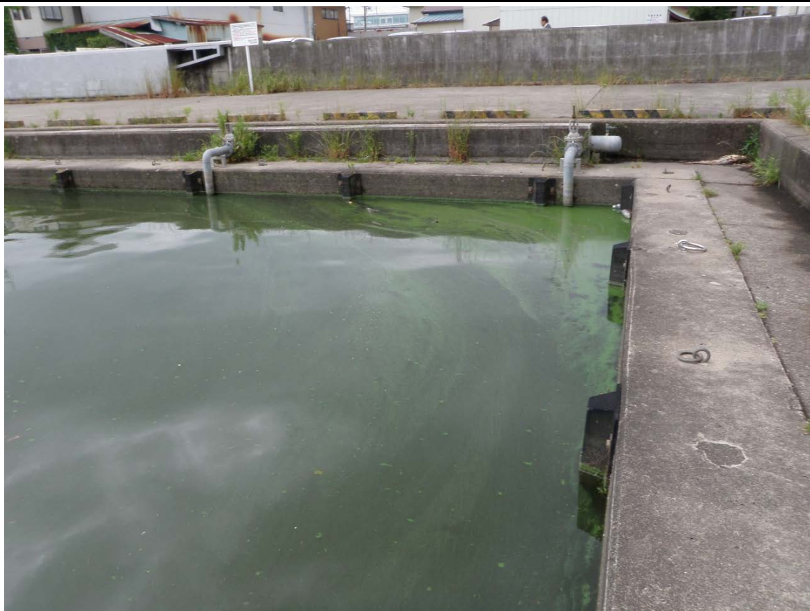
西浦中岸1.25km+150m レベル3~4
