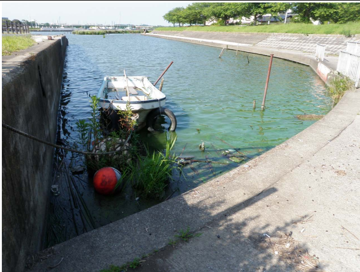
西浦中岸1.00km-50m レベル3~4
