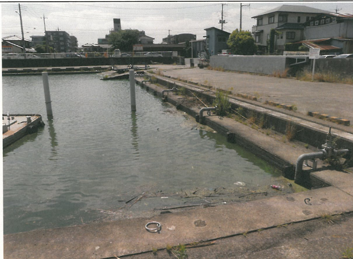
西浦中岸1.25km+200m レベル3~4
