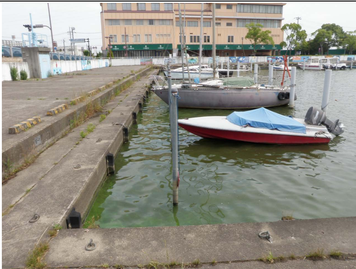
西浦中岸1.50km-150m レベル3~4
