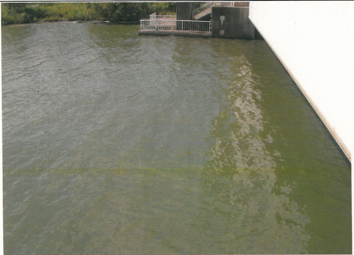
西浦右岸47.25km+50m 備前川 レベル3~4
