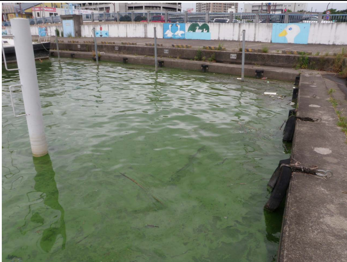
西浦中岸1.50km-150m レベル3~4
