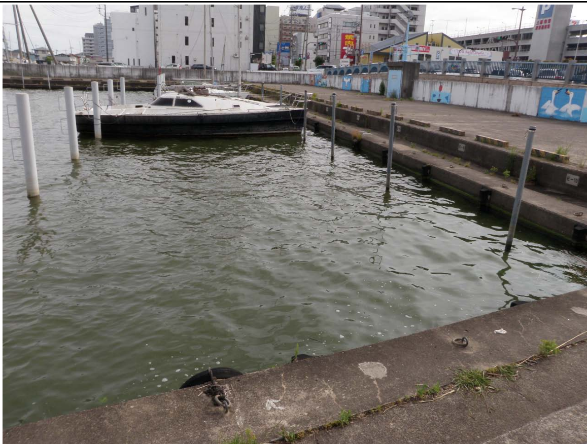
西浦中岸1.50km-100m レベル2~3
