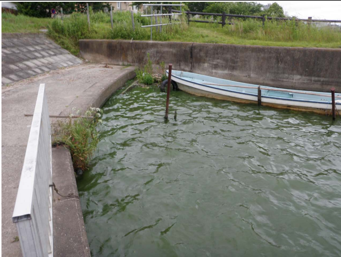
西浦中岸1.00km-50m レベル3~4
