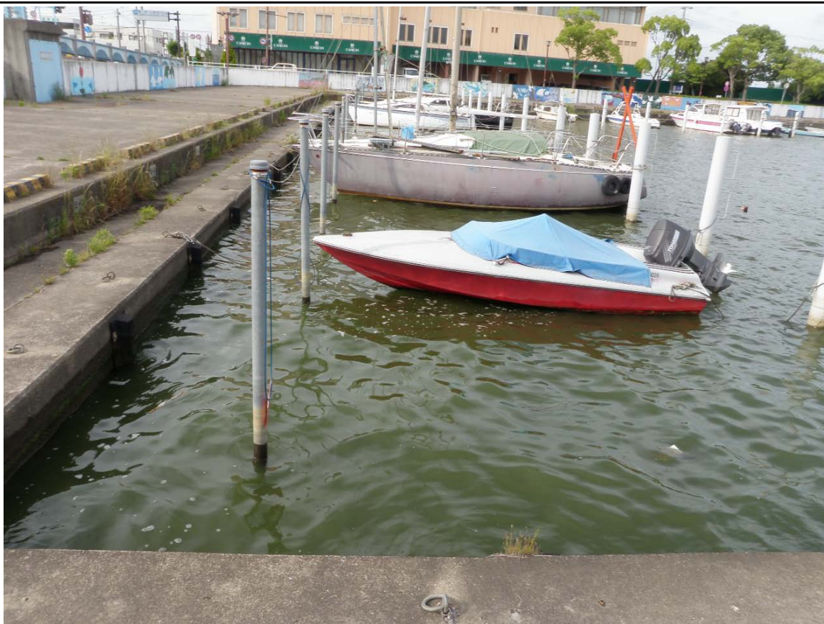
西浦中岸1.50km-150m レベル2~3
