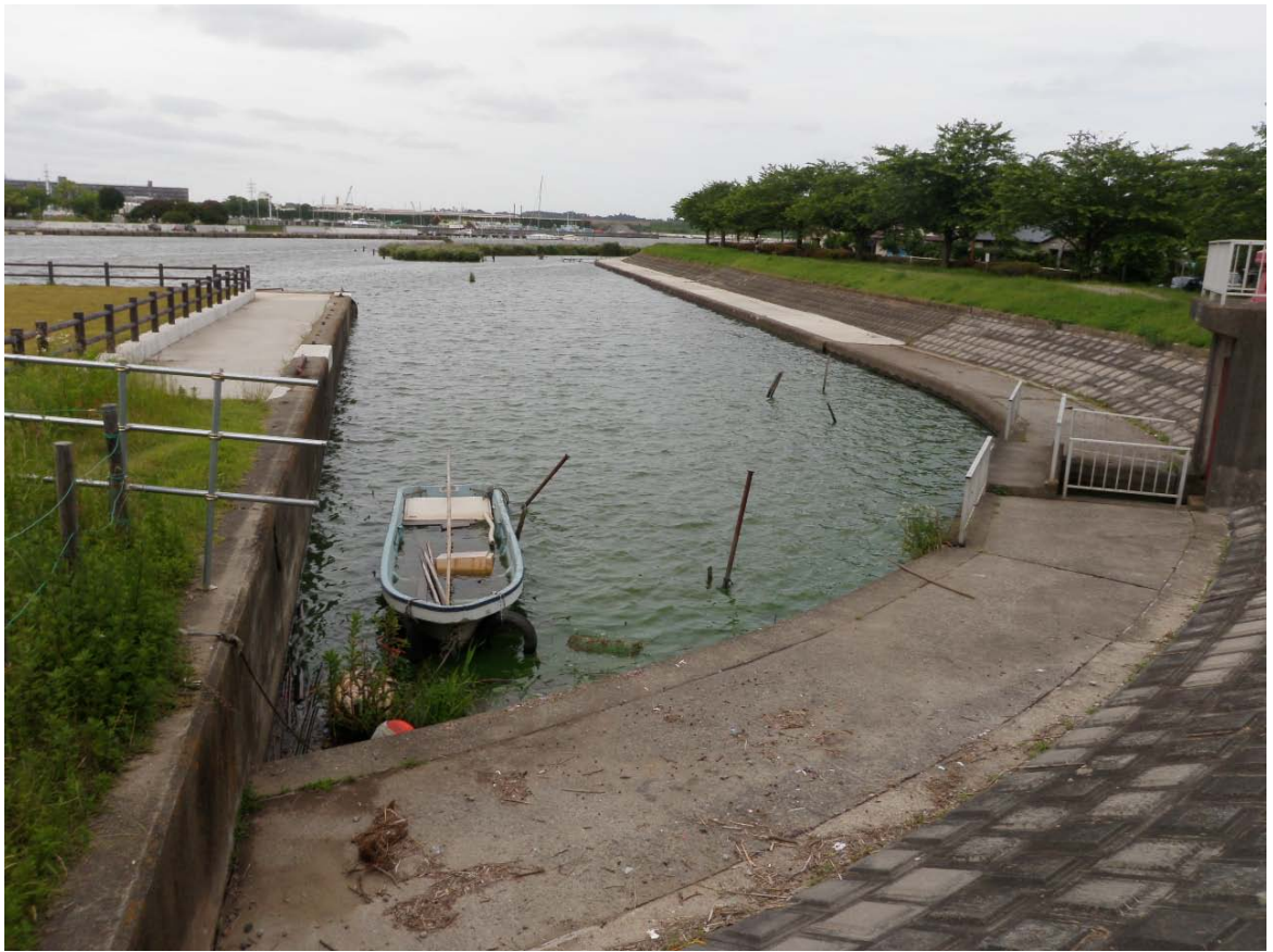
西浦中岸1.00km-50m レベル3~4
