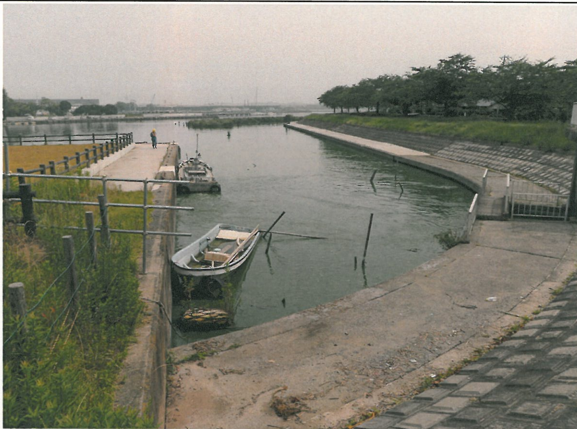
西浦中岸1.00km-50m レベル3~4 (9:20確認) 攪拌作業実施中
