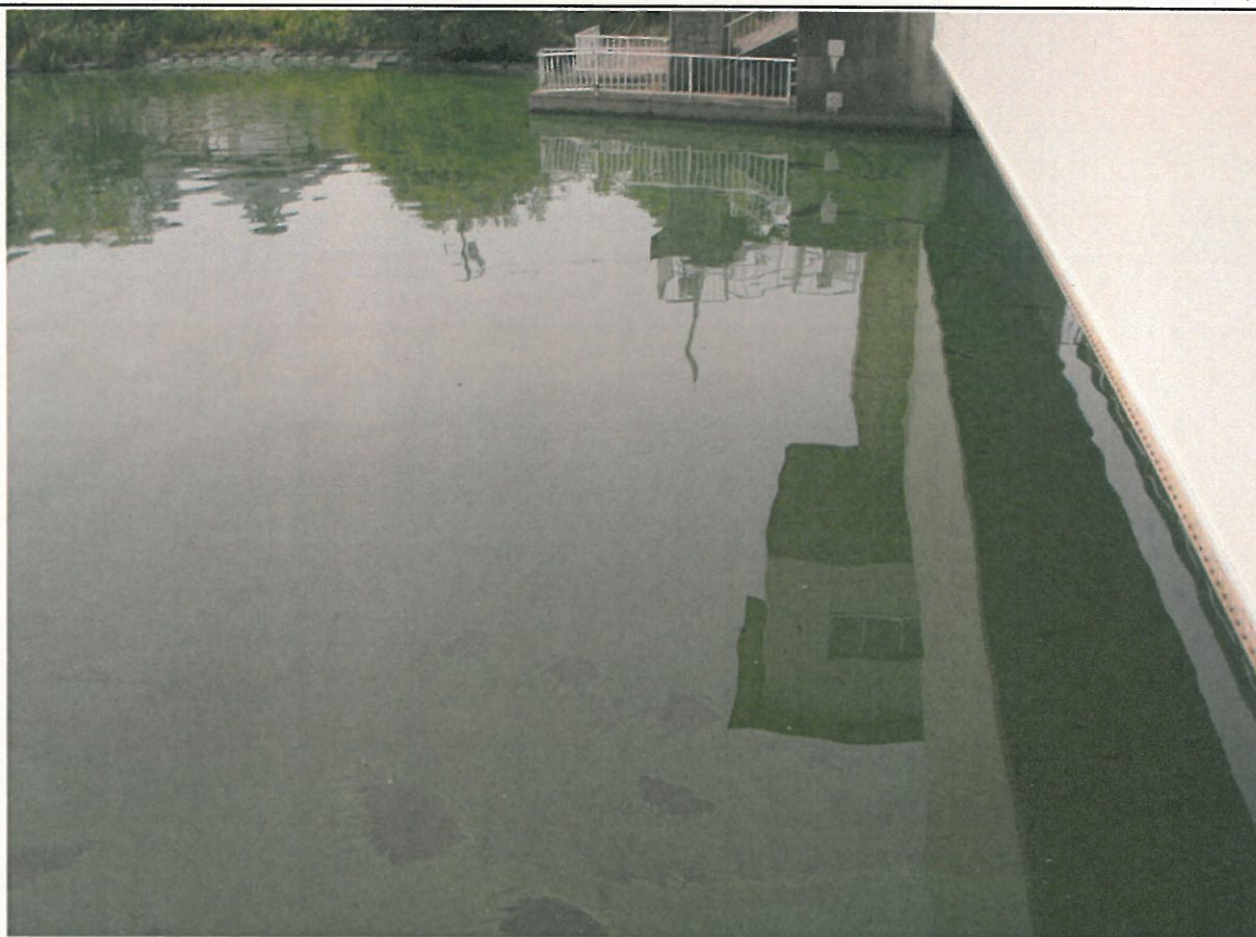
西浦右岸47.25km+50m 備前川 レベル4
