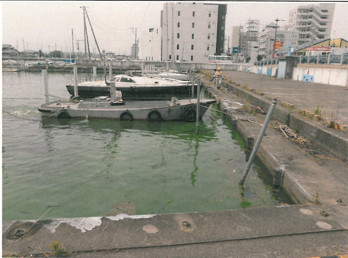
西浦中岸1.50km-100m レベル4 (9:30確認) 攪拌作業実施中
