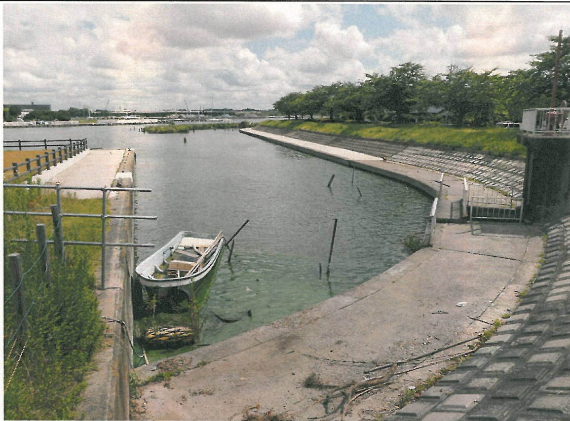
西浦中岸1.00km-50m レベル3~4
