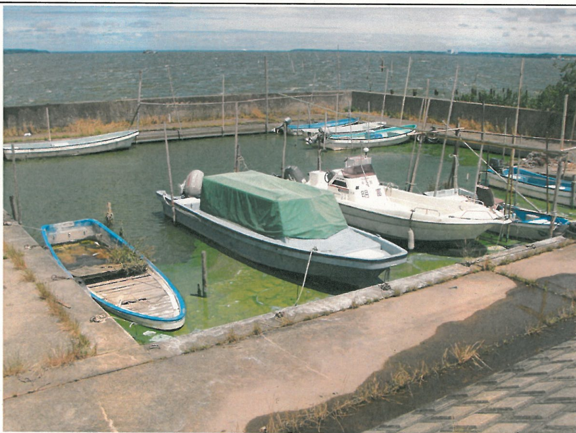
西浦右岸46.5km+70m レベル3~5
