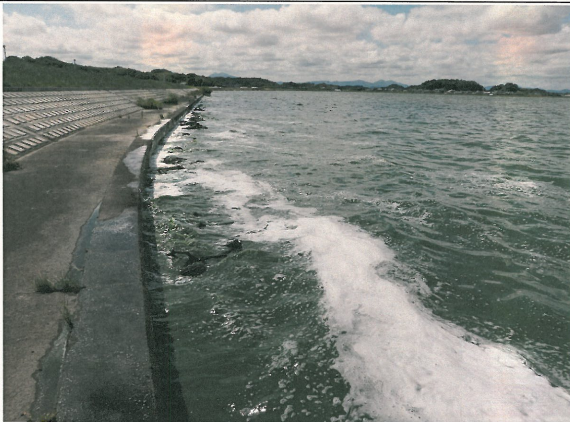
西浦中岸31.00km レベル3~4
