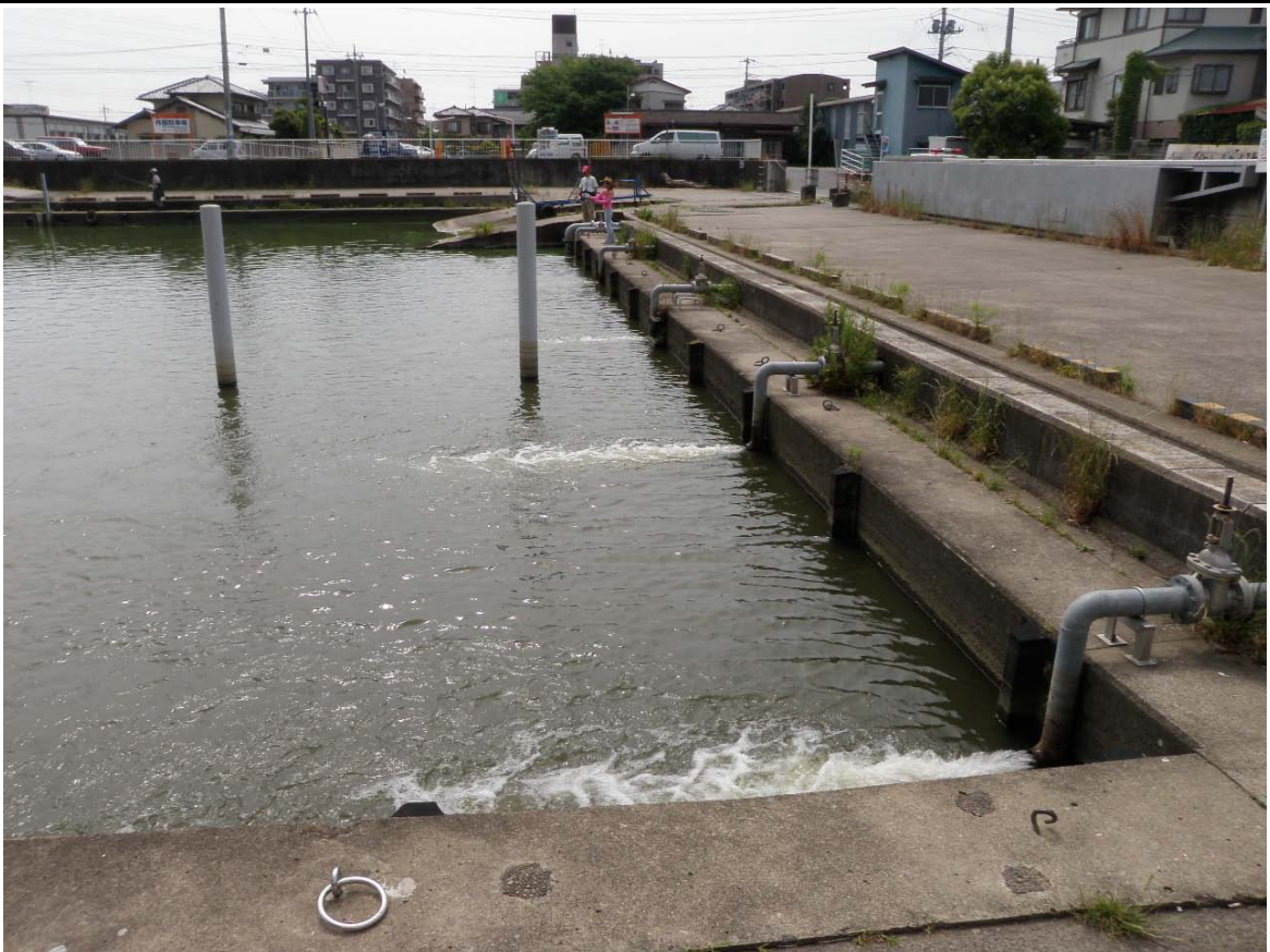
西浦中岸1.25km+200m レベル2
