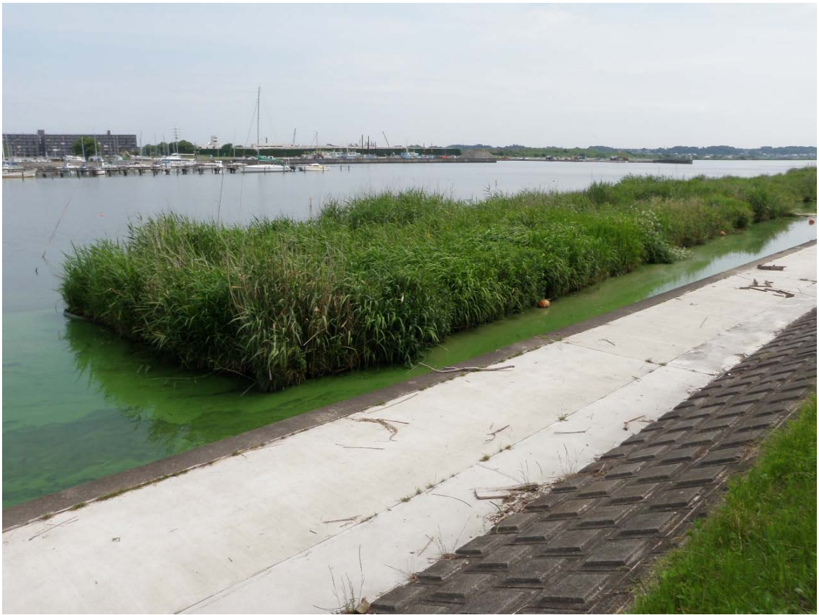
西浦中岸0.75km レベル3~4
