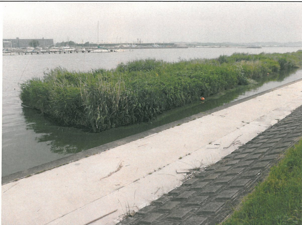
西浦中岸0.75km レベル3~4
