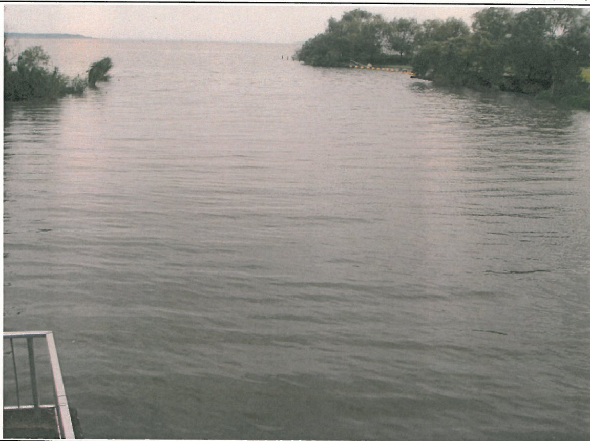
西浦右岸47.25km+50m 備前川 レベル2~3
