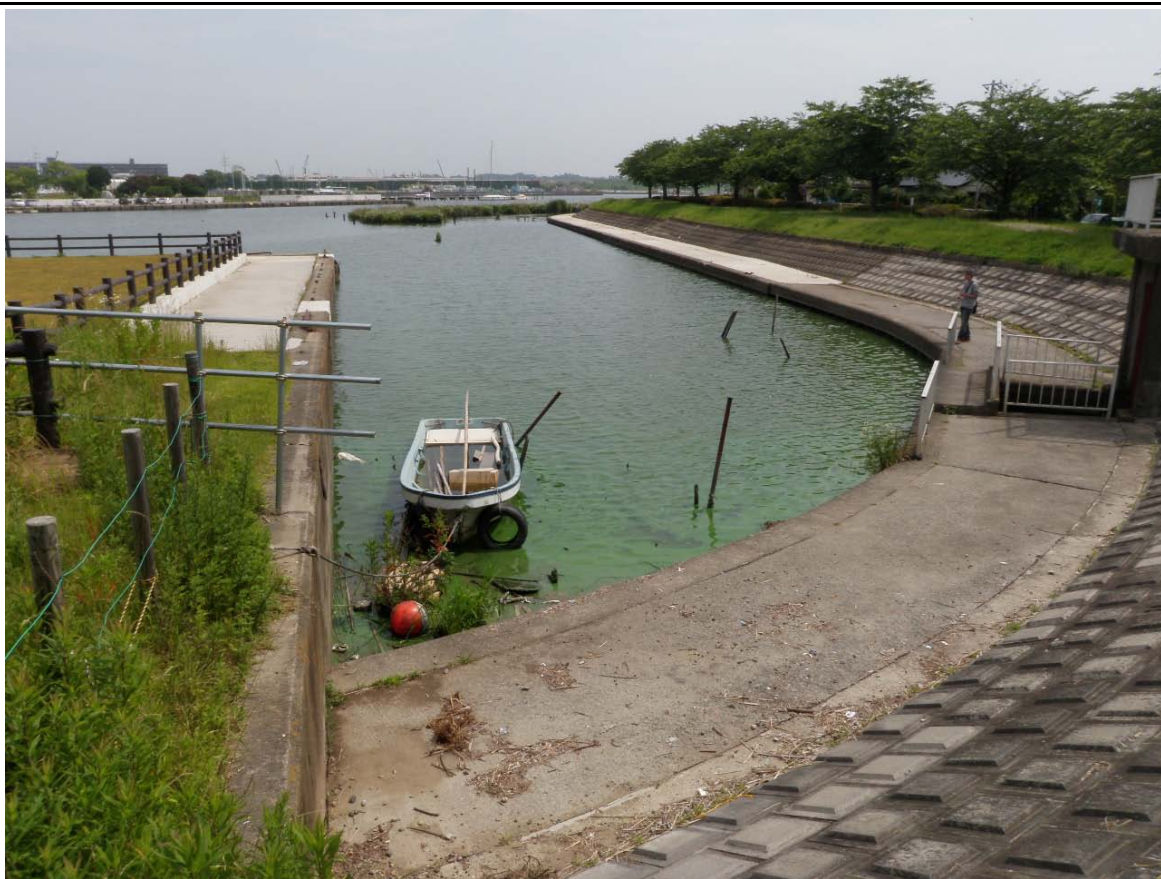
西浦中岸1.00km-50m レベル3~4
