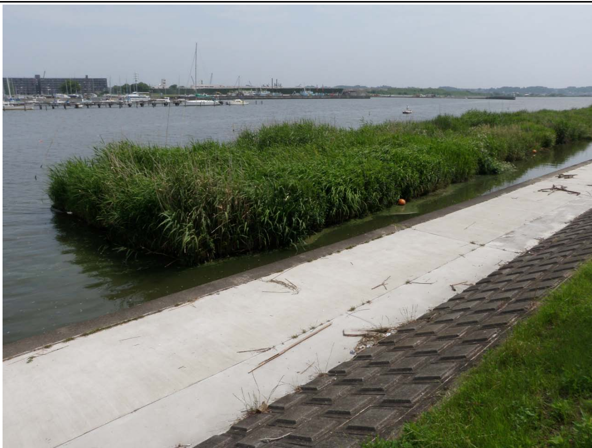
西浦中岸0.75km-50m レベル2~3
