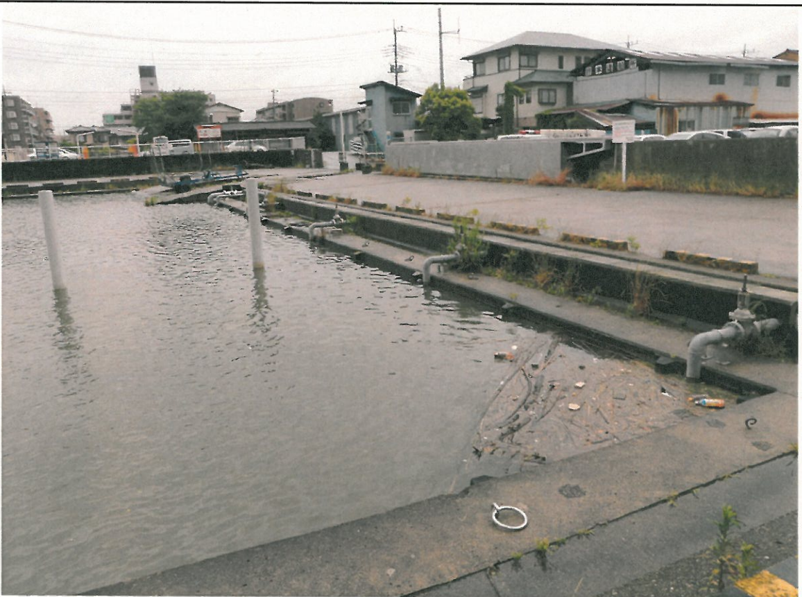
西浦中岸1.25km+200m レベル2~3
