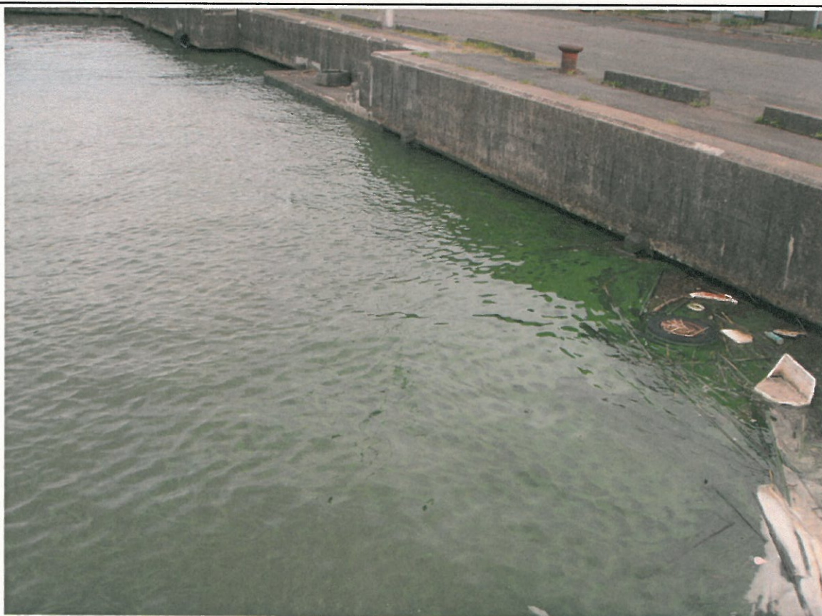
西浦右岸48.5km+100m 霞ポート レベル3~4
