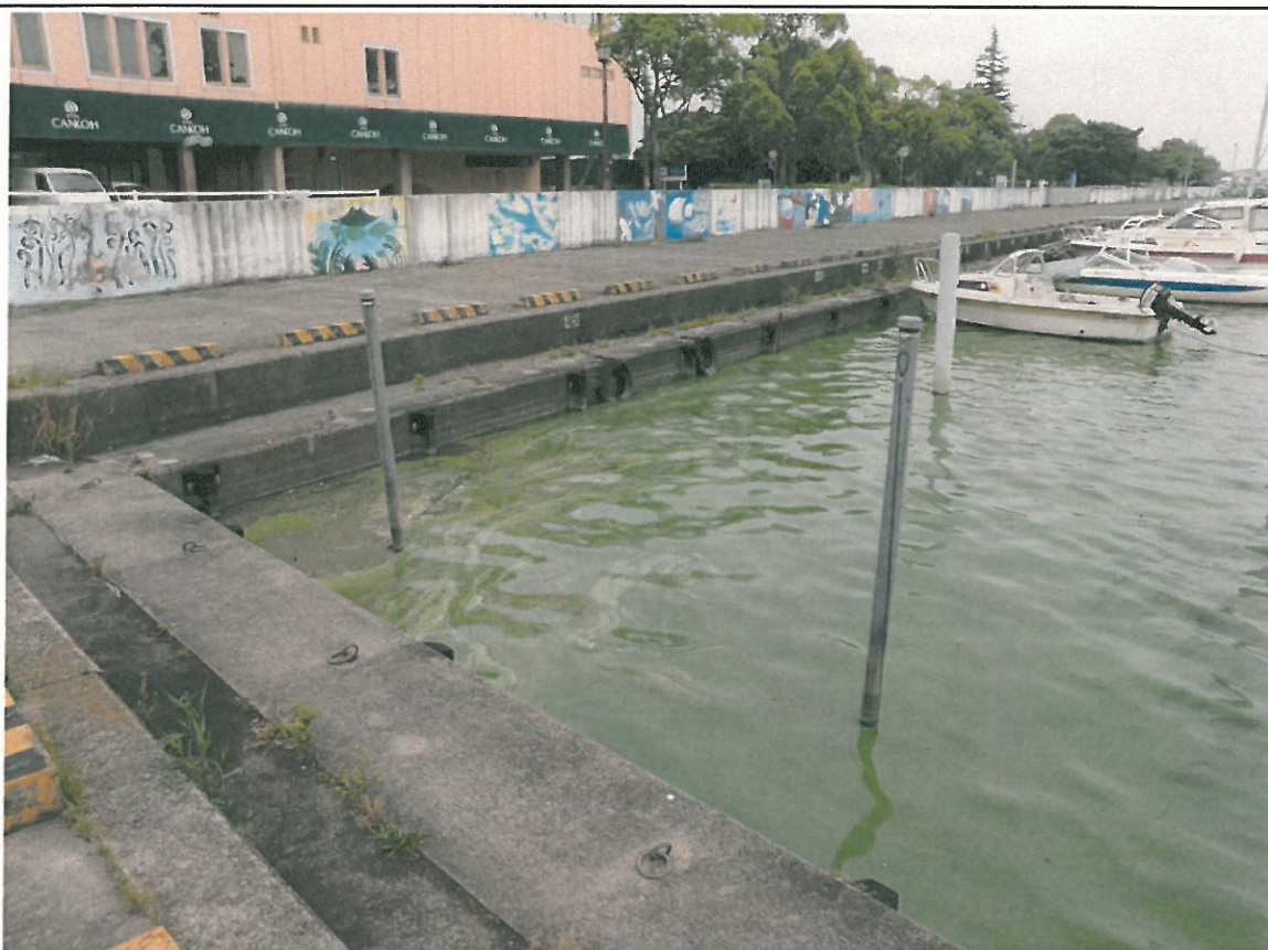
西浦中岸1.50km-100m レベル4
