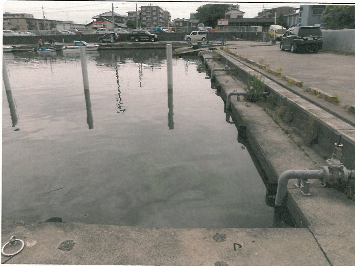
西浦中岸1.25km+200m レベル2~3
