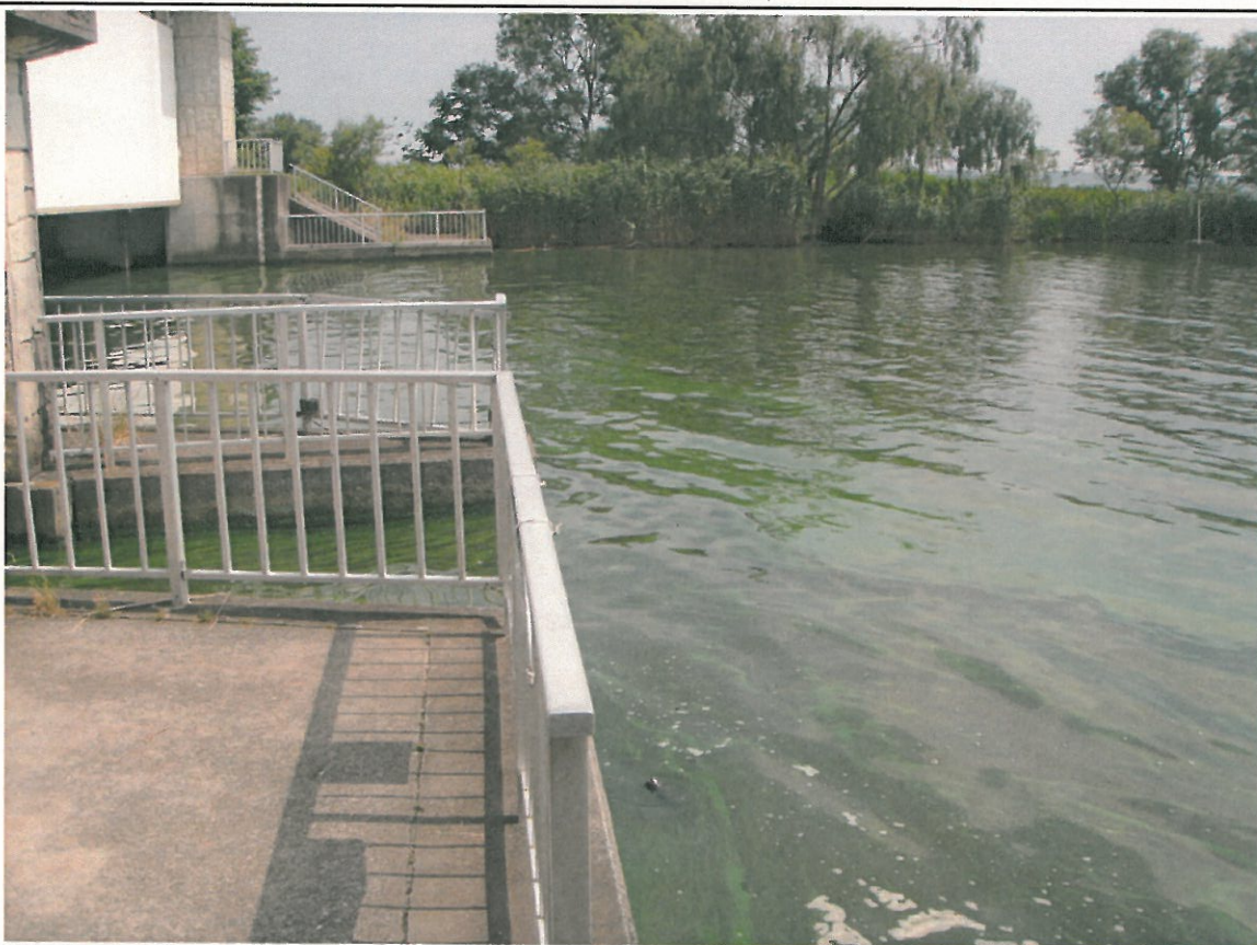
西浦右岸47.25km+50m 備前川 レベル3~4
