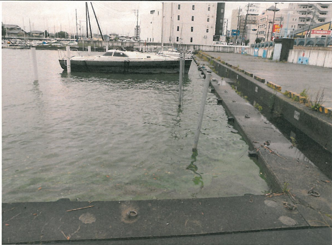
西浦中岸1.50km-100m レベル3~4
