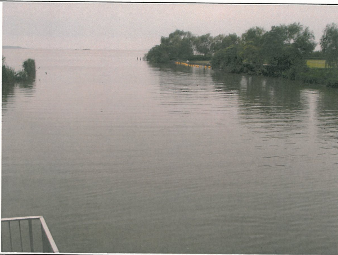
西浦右岸47.25km+50m 備前川 レベル3
