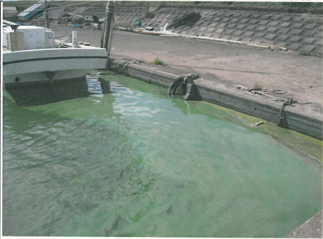
北浦右岸24. 25km+50 繁昌舟溜り レベル4 無臭
