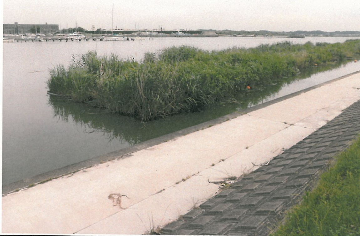
西浦中岸0.75km レベル3
