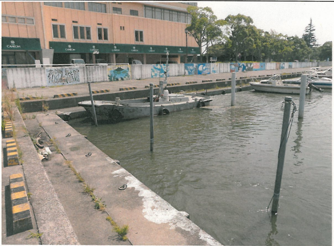
西浦中岸1.50km-100m アオコ攪拌作業によりレベル2 (9:35確認)
