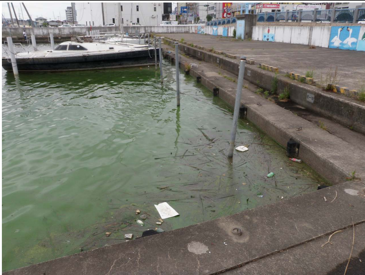
西浦中岸1.50km-150m レベル3~4
