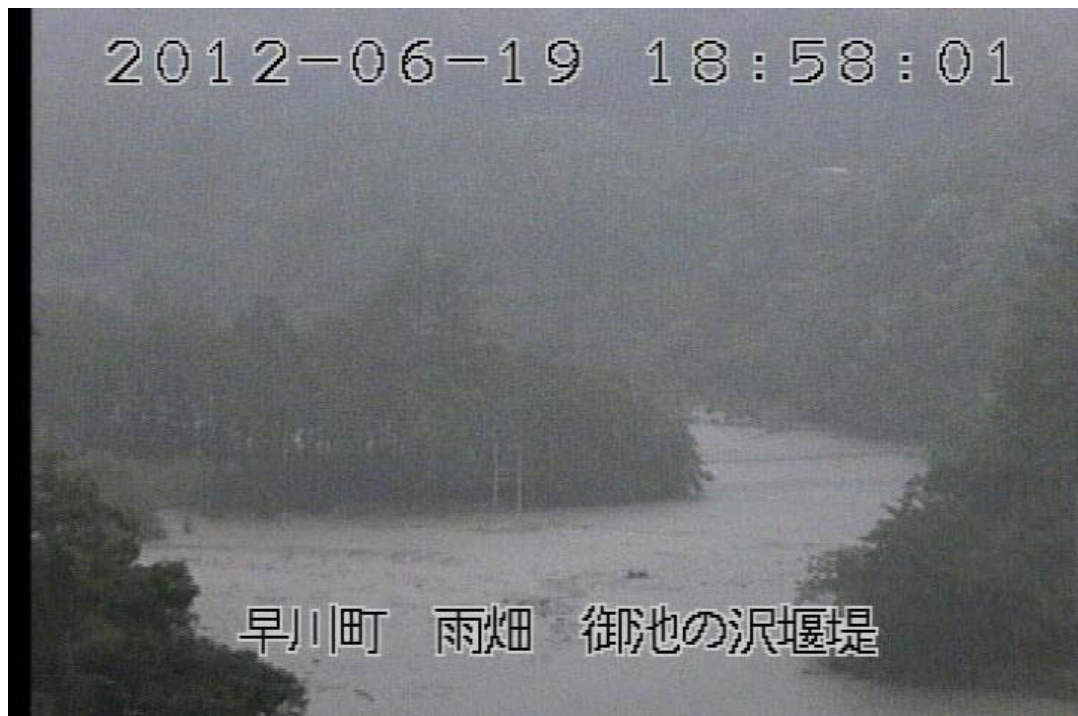
雨畑川【御池の沢合流部の上流】（6月19日19時頃）
