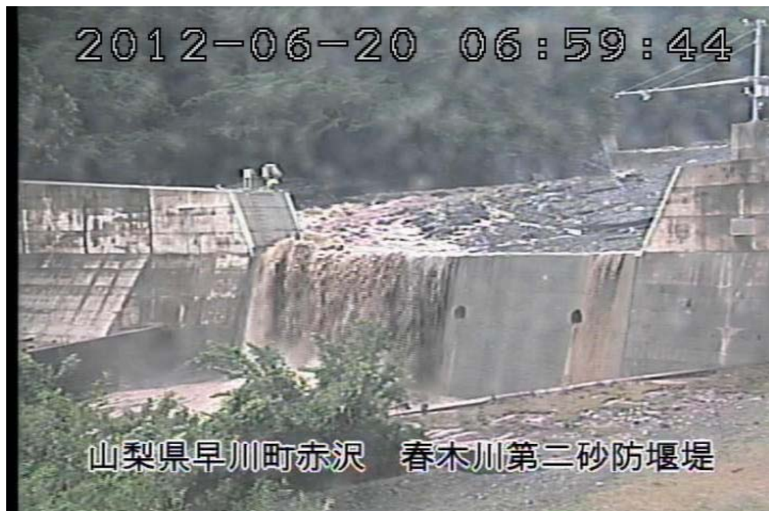
春木川第二砂防堰堤（6月20日7時頃）
