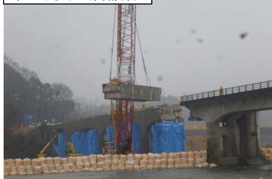
吊上げ状況（受桁部）
