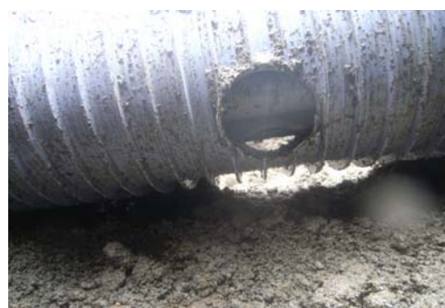
管路損傷状況
