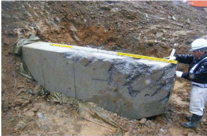
ウイング上流側破損状況
