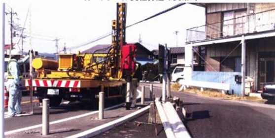
ガードレール支柱打ち込み異常時
