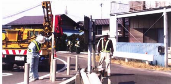
ガードレール支柱打ち込み完了(情報ボックス損傷)
