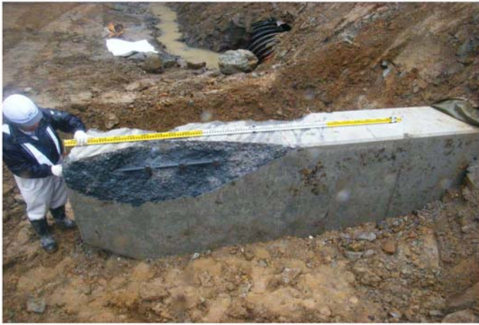
ウイング下流側破損状況
