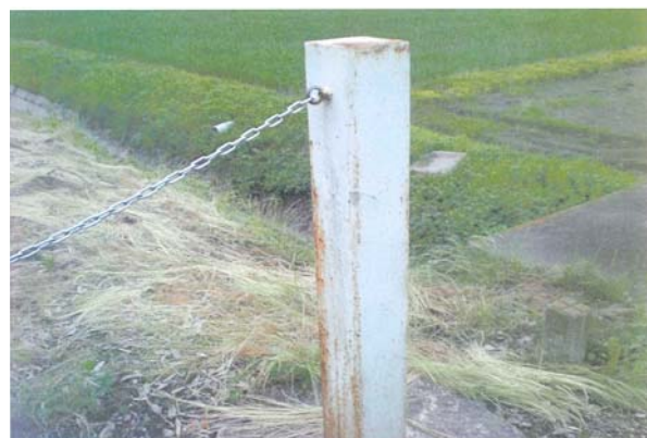
接触した鉄製ポール
