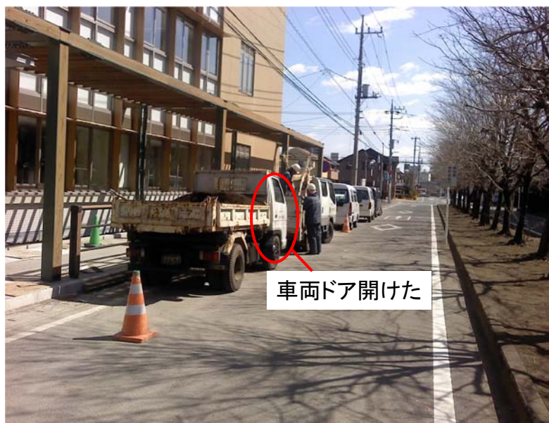
事故発生時規制状況(カラーコーンのみ)
