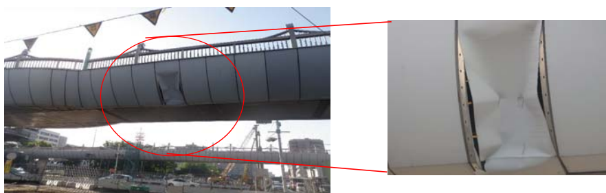
歩道橋損傷状況
