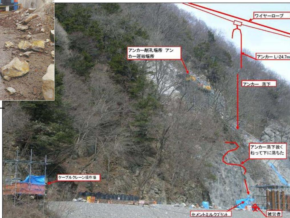
・アンカー（24.7m、約185kg）を法面上の作業床に運搬するため、ケーブルクレーンで吊り上げて移動をさせた。
