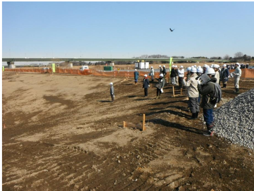
堂本委員による掘削地の工事指導状況の見学
