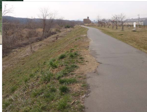
伐採後の状況
