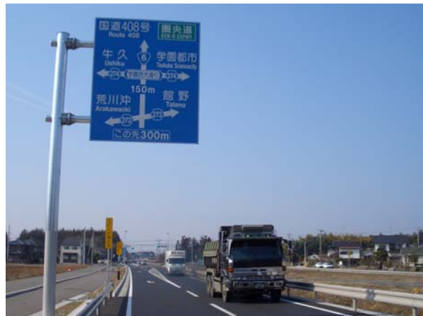
学園東大通り側から学園西大通りを望む (H24.2撮影)
