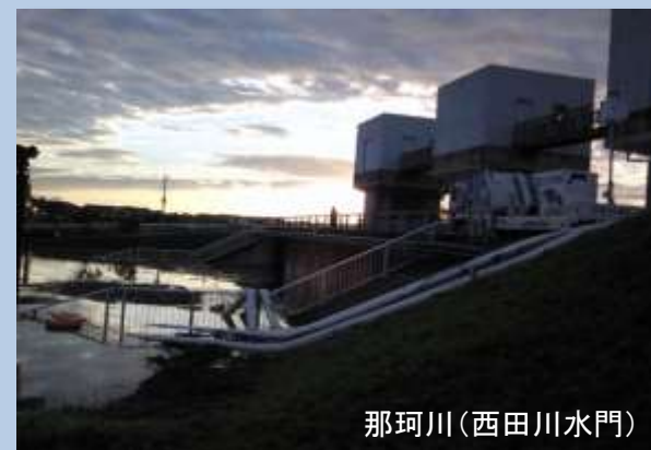
ポンプ排水車による内水排除
