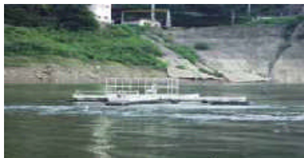
散気管式浅層曝気循環設備
