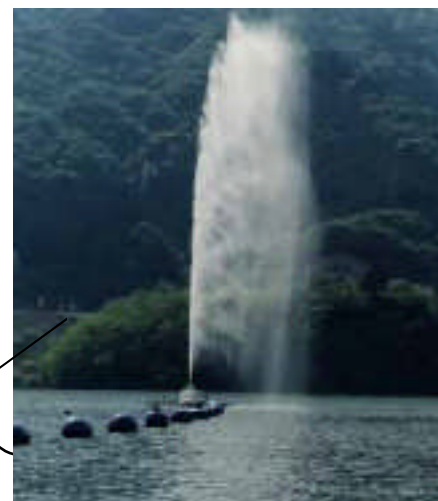
噴水合体型 散気管式浅層曝気循環設備
