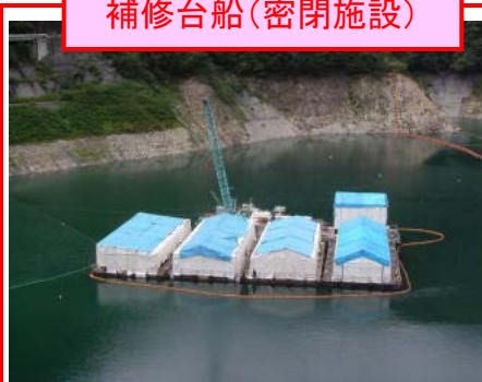
補修台船(密閉施設)
