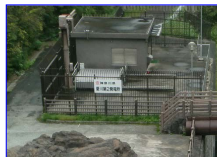
愛川第2発電所
