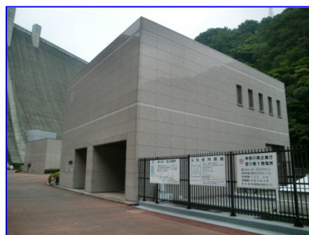
愛川第1発電所
