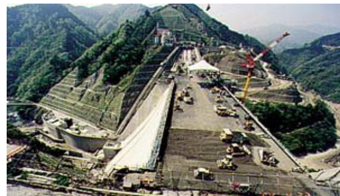
本体コンクリート打設状況
