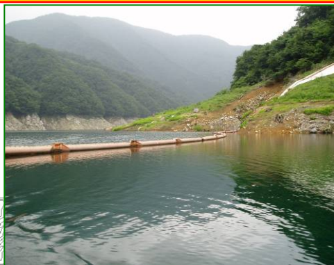
濁水拡散防止フェンス
