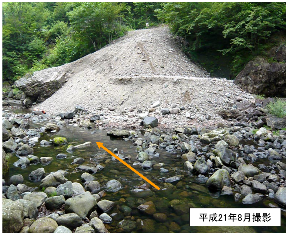
置き土の状況(上流右岸側)
