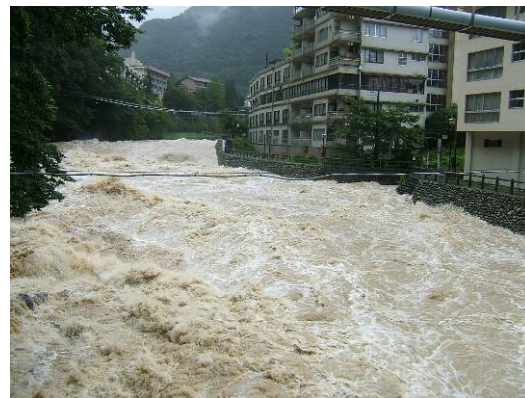
H19年9月の台風9号出水における五十里ダム下流(川治温泉街)の状況
