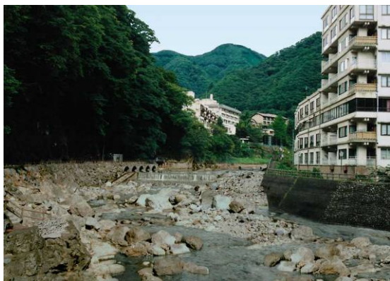
平常時の五十里ダム下流(川治温泉街)の状況
