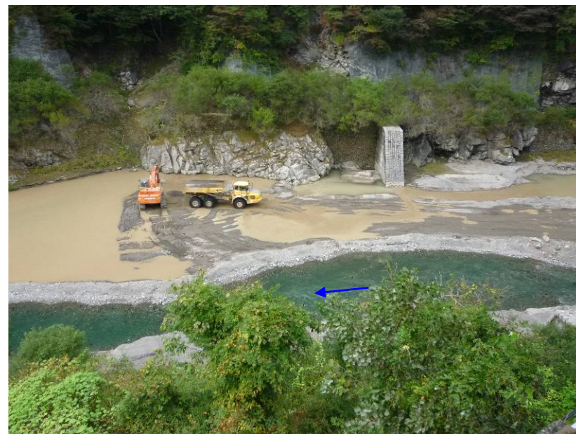
貯砂ダムと砂利掘削の状況
