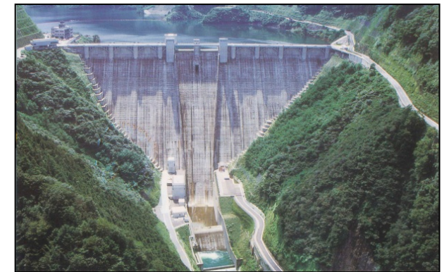
【浦山ダムの全景】
