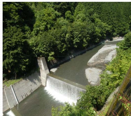
貯砂ダム(搬出前)
