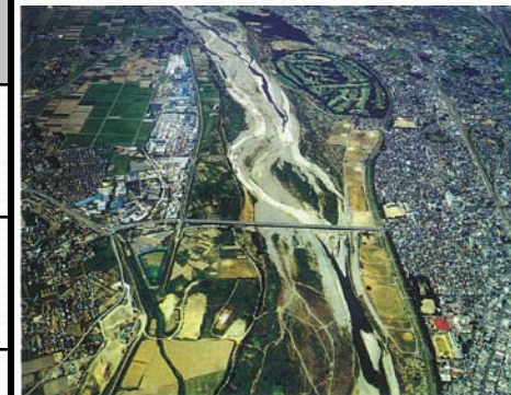
瀬切れの発生状況 (平成4年9月 荒川大橋)
