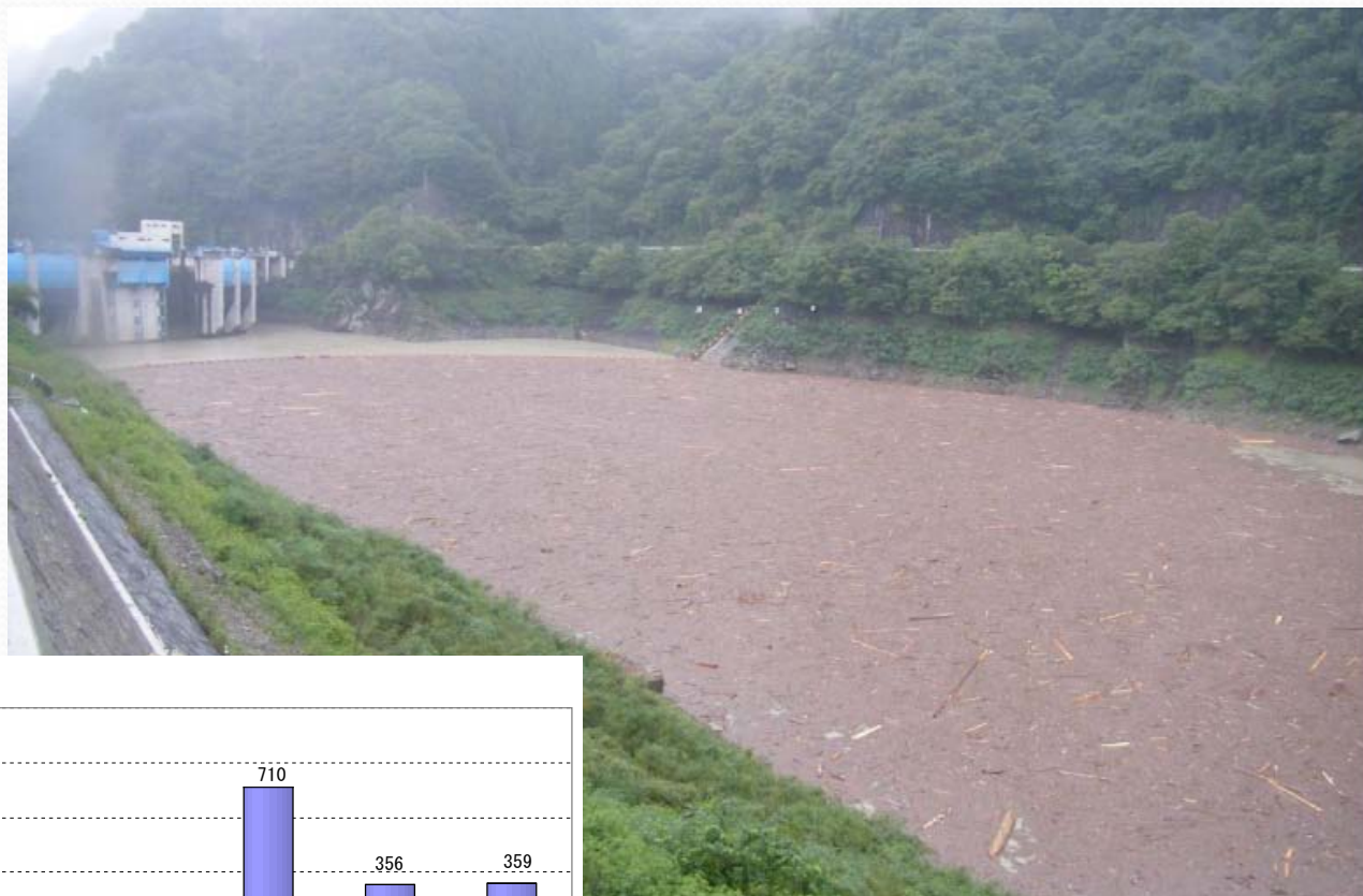
二瀬ダム貯水池内の流木捕捉状況(H19.9台風9号)
