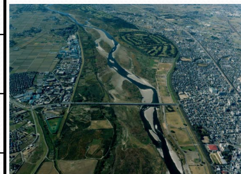
通常(瀬切れのない)時の流れ (平成18年 荒川大橋)
