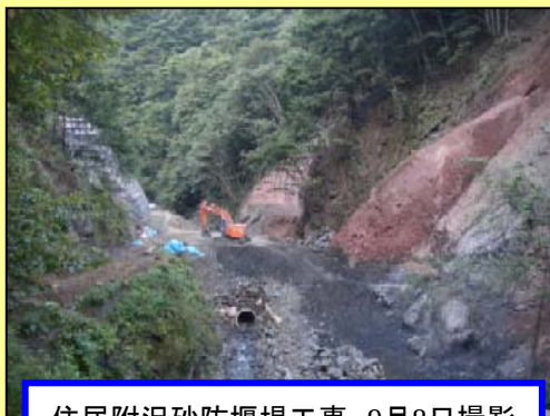
住居附沢砂防堰堤工事 9月8日撮影
