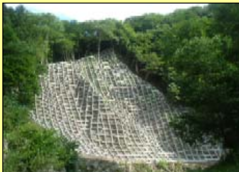
H20野栗沢山腹工工事 8月31撮影
