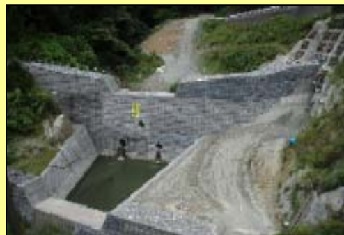
平成20年度境沢砂防堰堤工事 9月9日撮影
