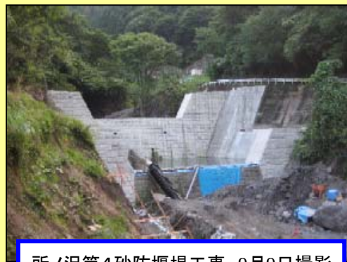
所ノ沢第4砂防堰堤工事 9月9日撮影
