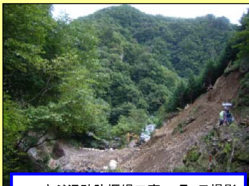
H20さぶ沢砂防堰堤工事 9月9日撮影
