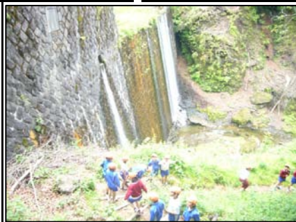
砂防堰堤の高さを実感
