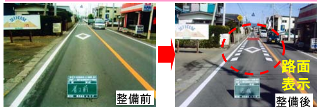
対策事例: 路面への「追突注意」の表示 (国道254号甘楽町)
