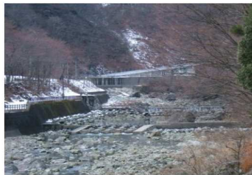
五十里ダム直下流の状況
