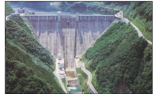
【浦山ダムの全景】
