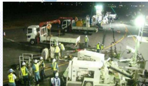
限られた時間での夜間作業
